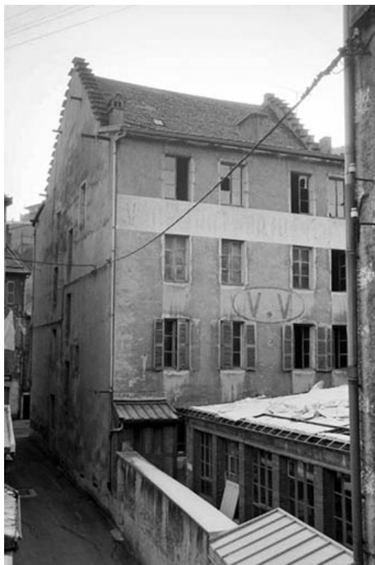
Immeuble : façade postérieure de trois quarts gauche.
