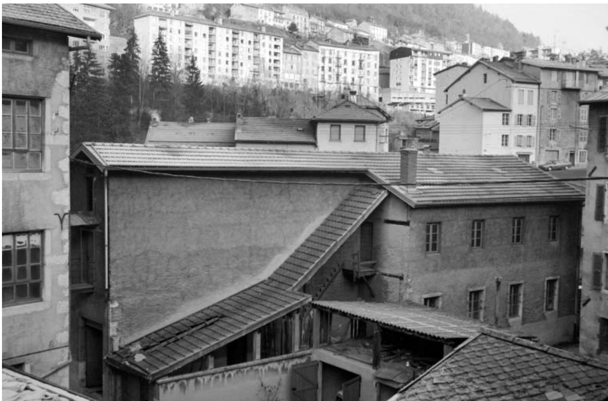
Séchoir à ébauchons : façade latérale droite. 39, Saint-Claude, 4, 8, 10 rue du Faubourg Marcel
