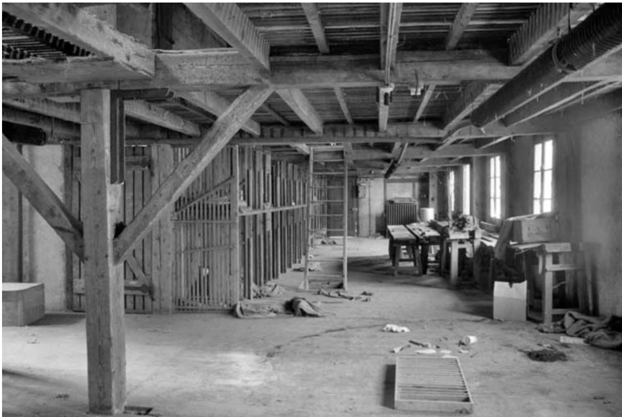
Séchoir à ébauchons : intérieur d'un atelier au rez-de-chaussée.
