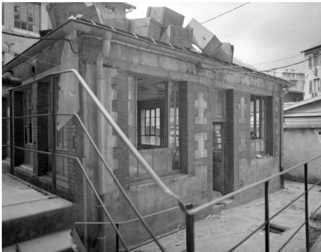
Atelier dans la cour : façade antérieure.
