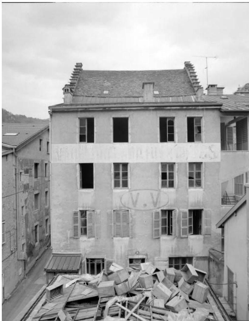
Immeuble : façade postérieure.
