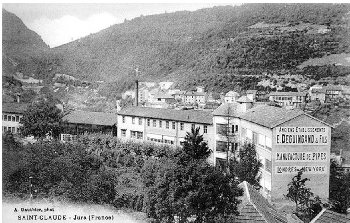
Saint-Claude - Jura (France) [vue d'ensemble de l'usine depuis l'est].
