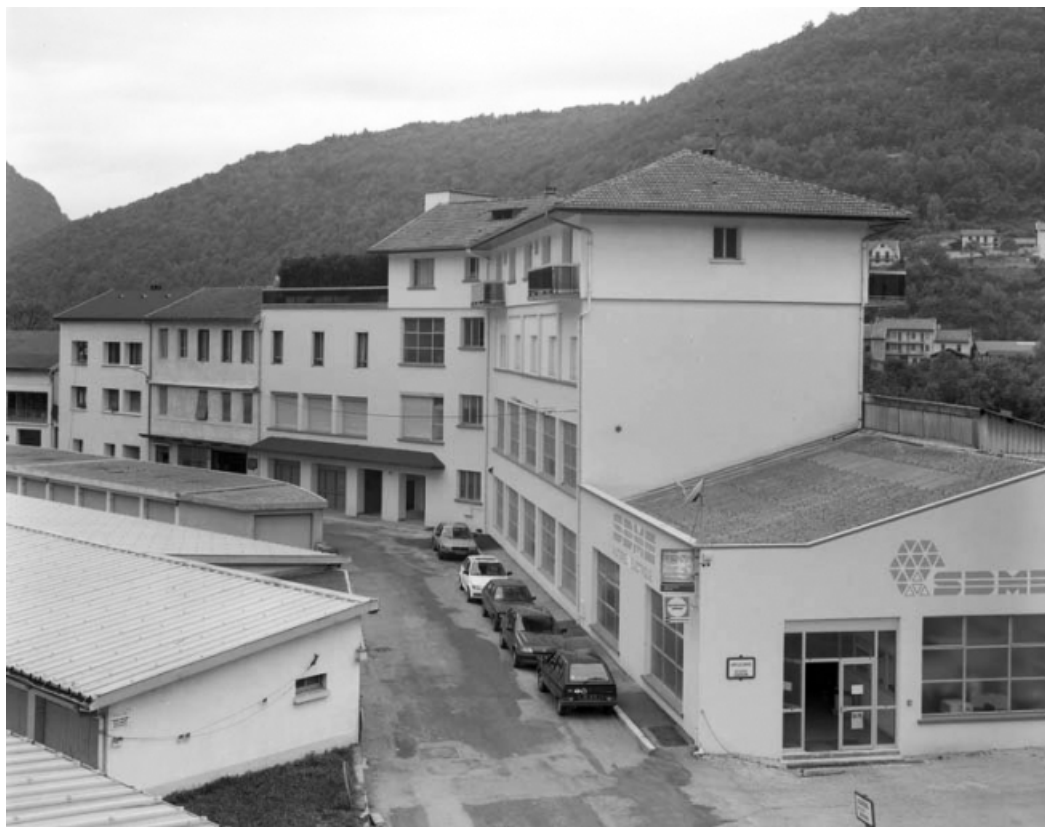
Façade antérieure de l'usine, de trois quarts droite.
