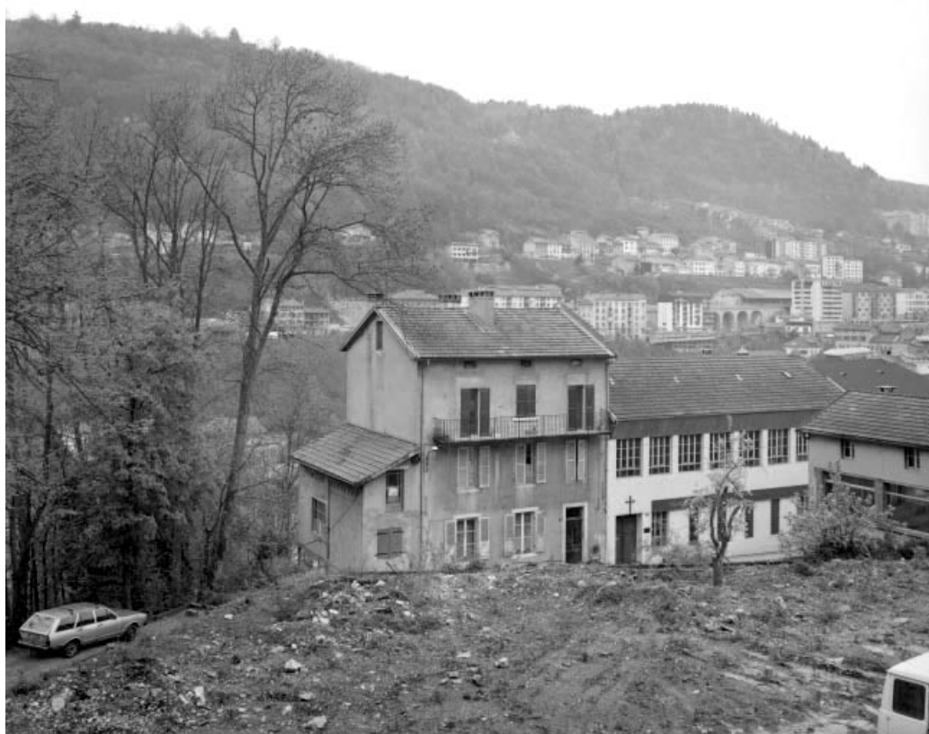
Vue d'ensemble de la façade antérieure.
