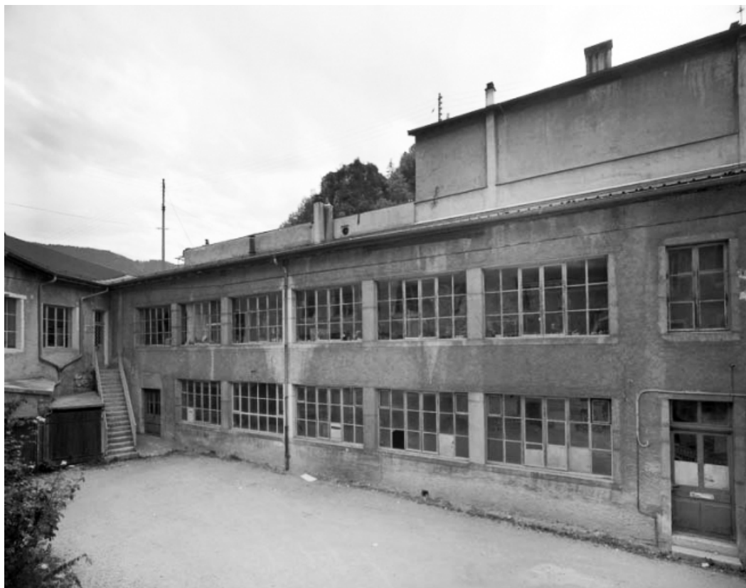
Bâtiments rue Carnot : façade antérieure de l'aile sud.
