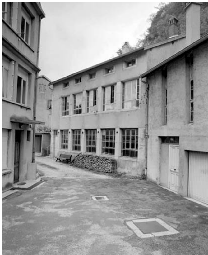
Atelier de fabrication chemin de la Combe du Marais, de trois quarts droite. 39, Saint-Claude, 2 chemin de la Combe du Marais
