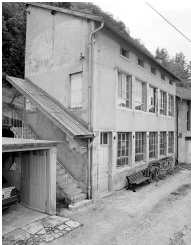
Atelier de fabrication chemin de la Combe du Marais, de trois quarts gauche. 39, Saint-Claude, 2 chemin de la Combe du Marais
