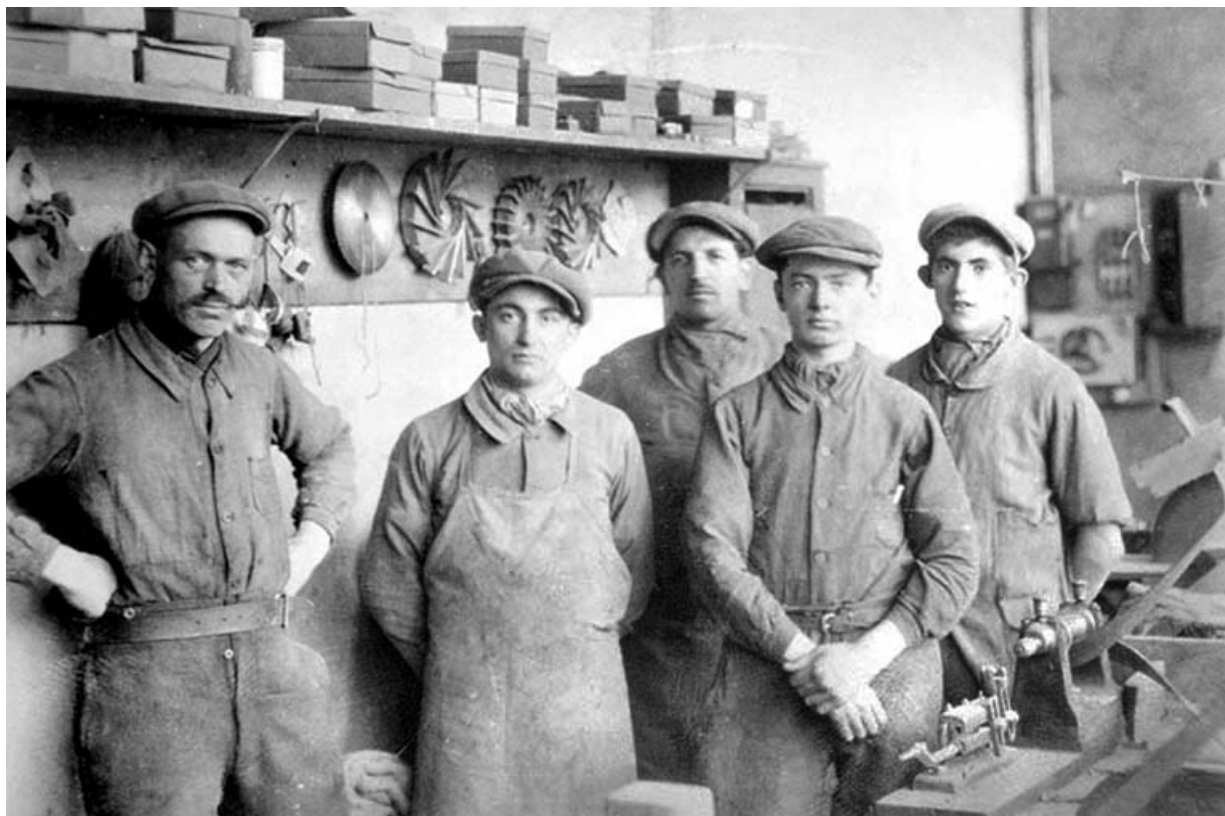
Intérieur de l'atelier Manzini à la Combe du Marais.
