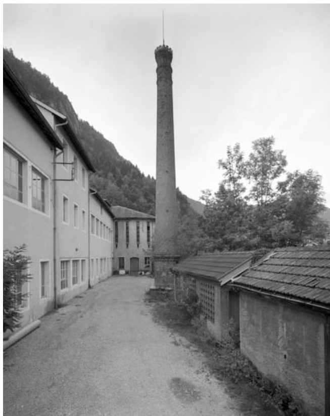
Façade postérieure des ateliers de fabrication et du séchoir à ébauchons.
