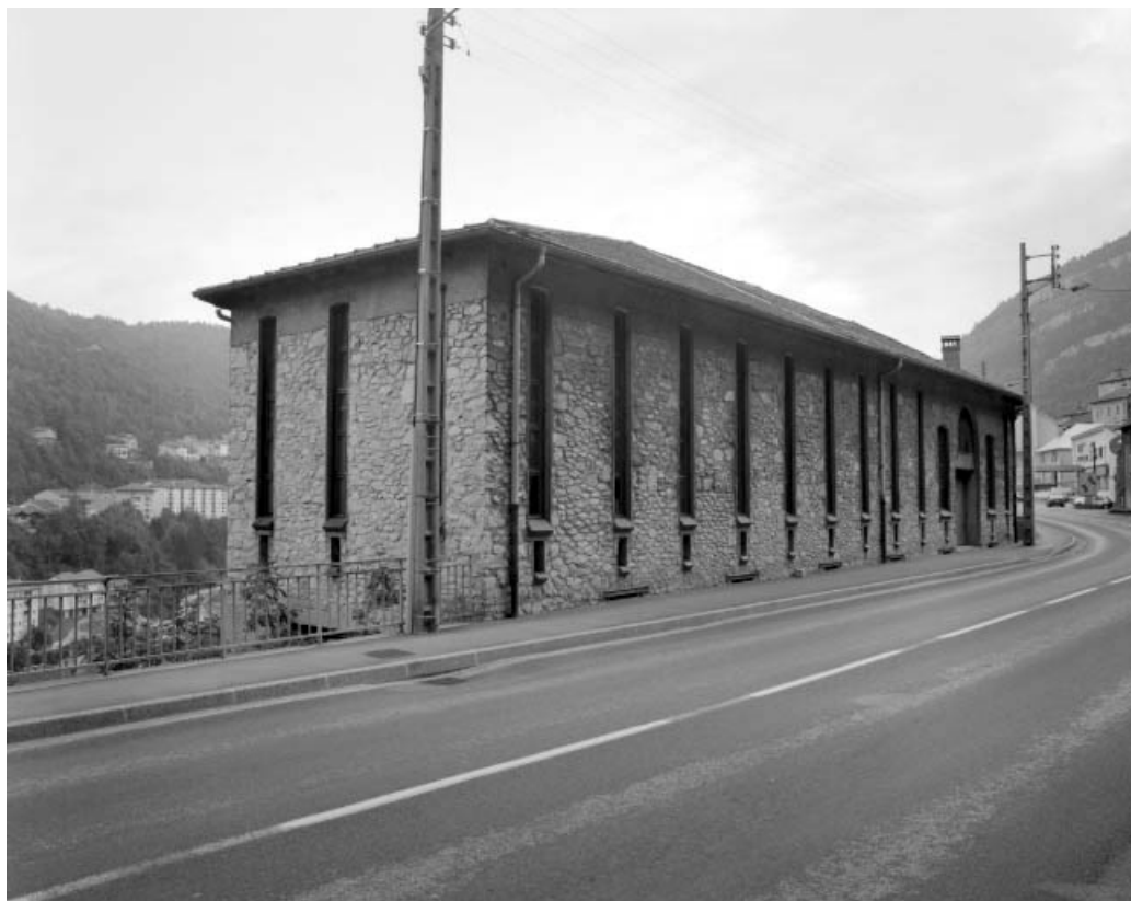
Façades antérieure et latérale droite du séchoir à ébauchons.
