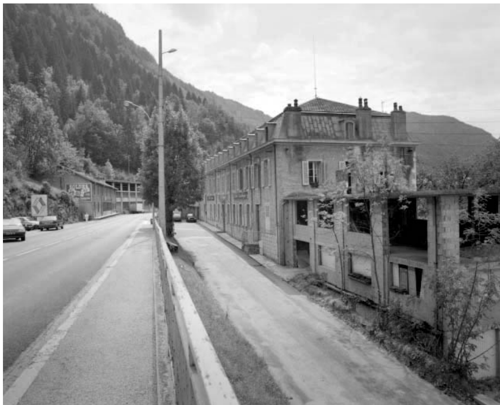
Vue d'ensemble depuis le nord-est et la rue Carnot.
