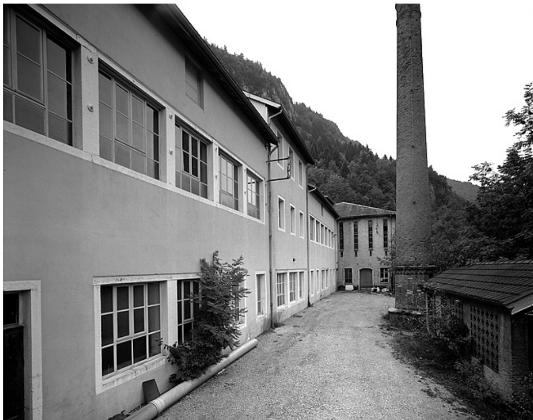
Façade postérieure des ateliers de fabrication et du séchoir à ébauchons.
