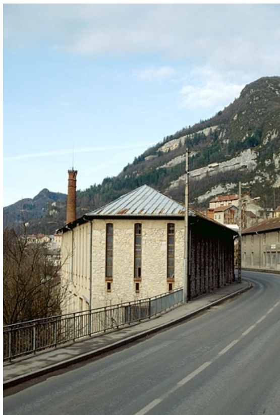
Façade latérale gauche du séchoir à ébauchons.
