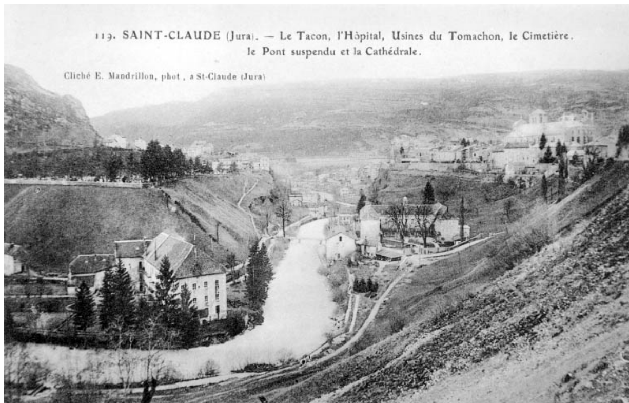
Saint-Claude (Jura).- Le Tacon, l'Hôpital, Usines du Tomachon, le Cimetière, le Pont Suspendu et la Cathédrale. 39, Saint-Claude Montée de l'Hôpital 1, 3
