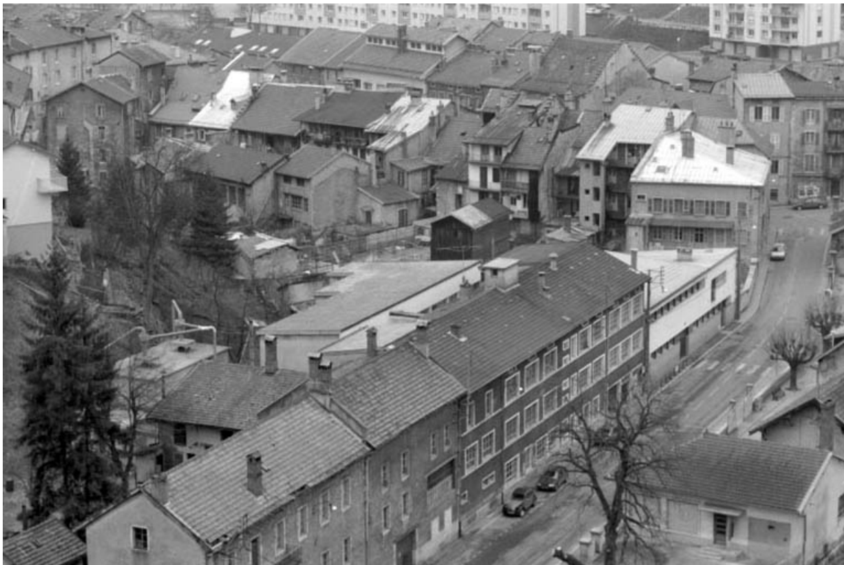
Vue d'ensemble plongeante sur l'usine depuis le nord-est.
