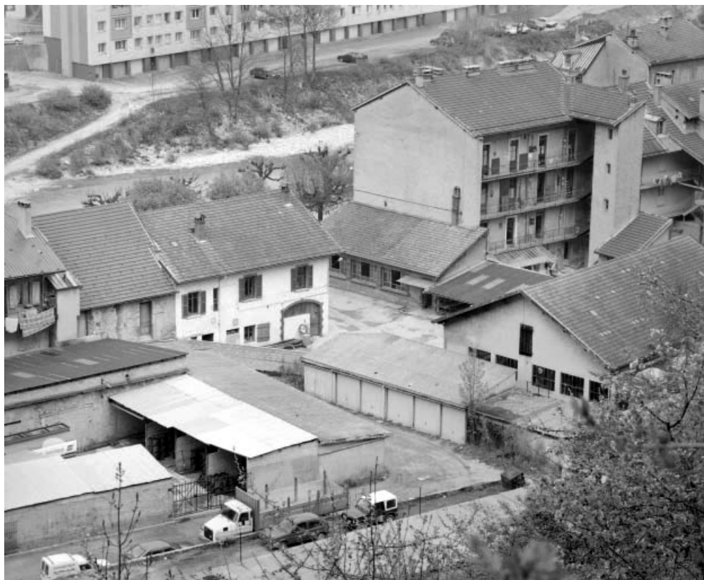
Logement, bureau et atelier de fabrication depuis le sud-est.
