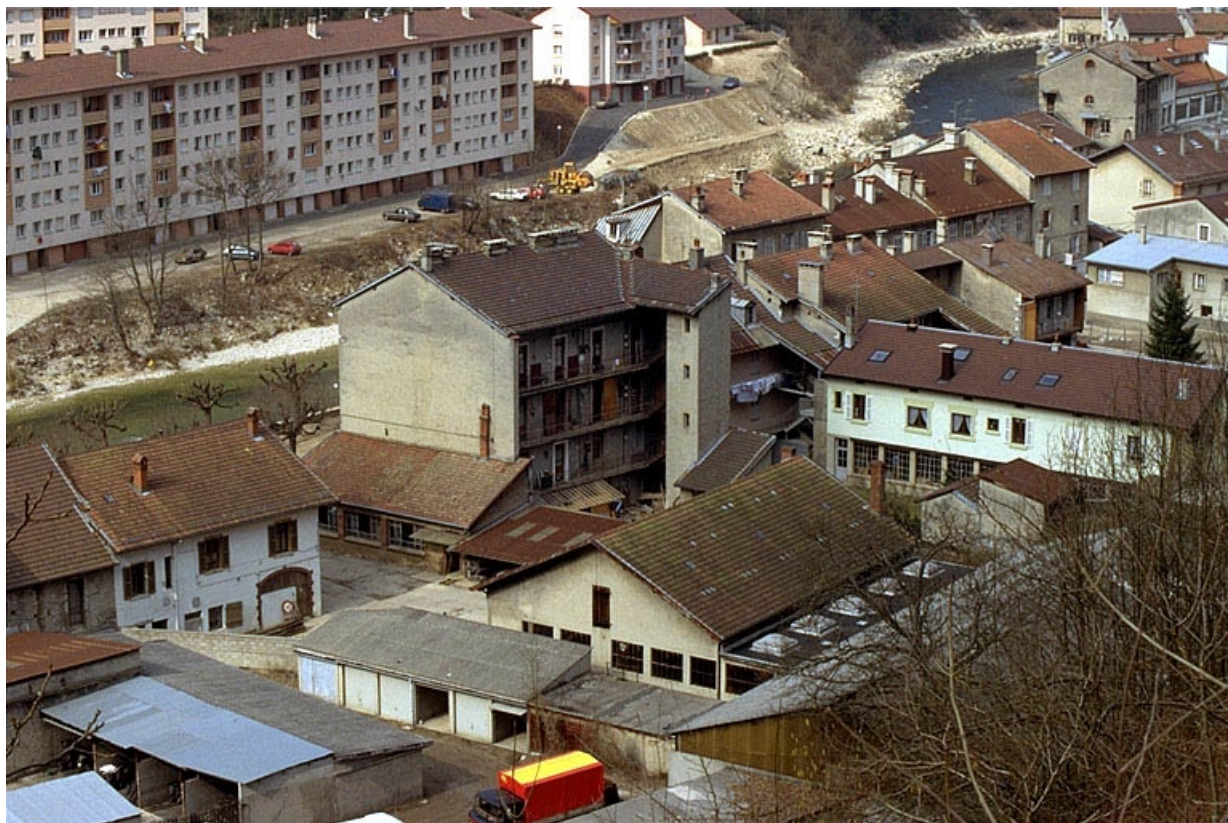
Vue d'ensemble plongeante depuis le sud-est. 39, Saint-Claude, 43 bis rue du Faubourg Marcel
