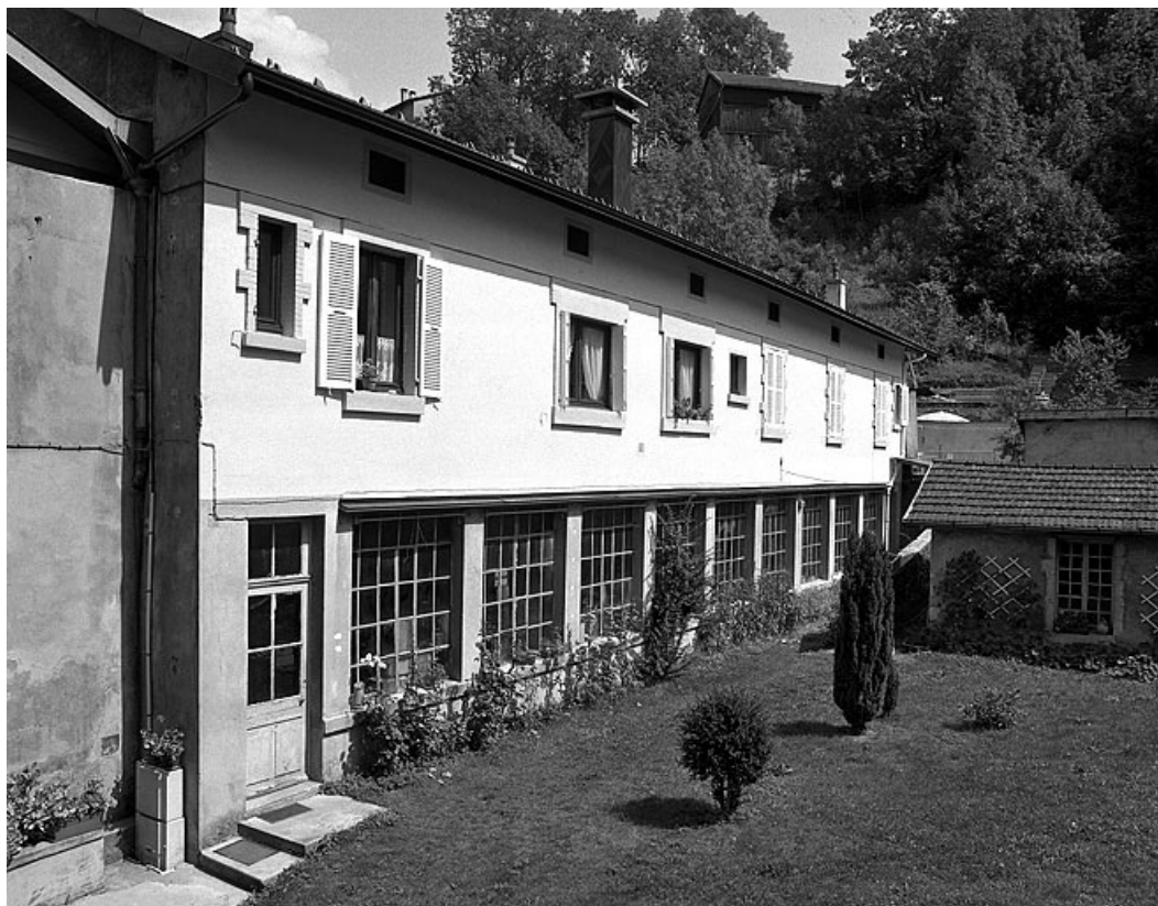
Façade antérieure de l'atelier de fabrication, de trois quarts gauche.
