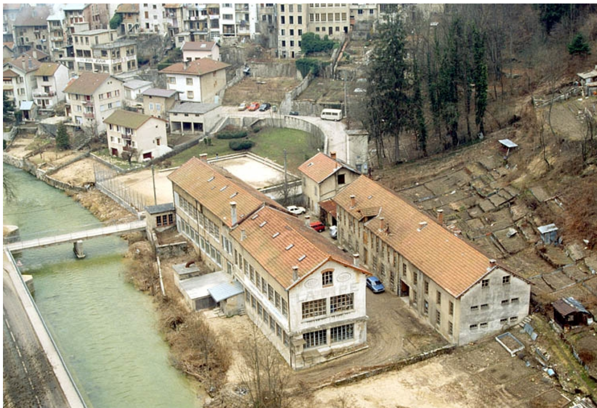
Vue d'ensemble plongeante depuis le sud-est.
