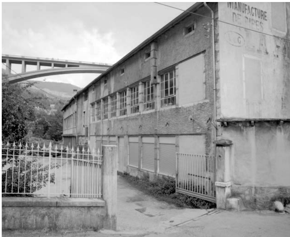
Façade sur cour des ateliers de fabrication.
