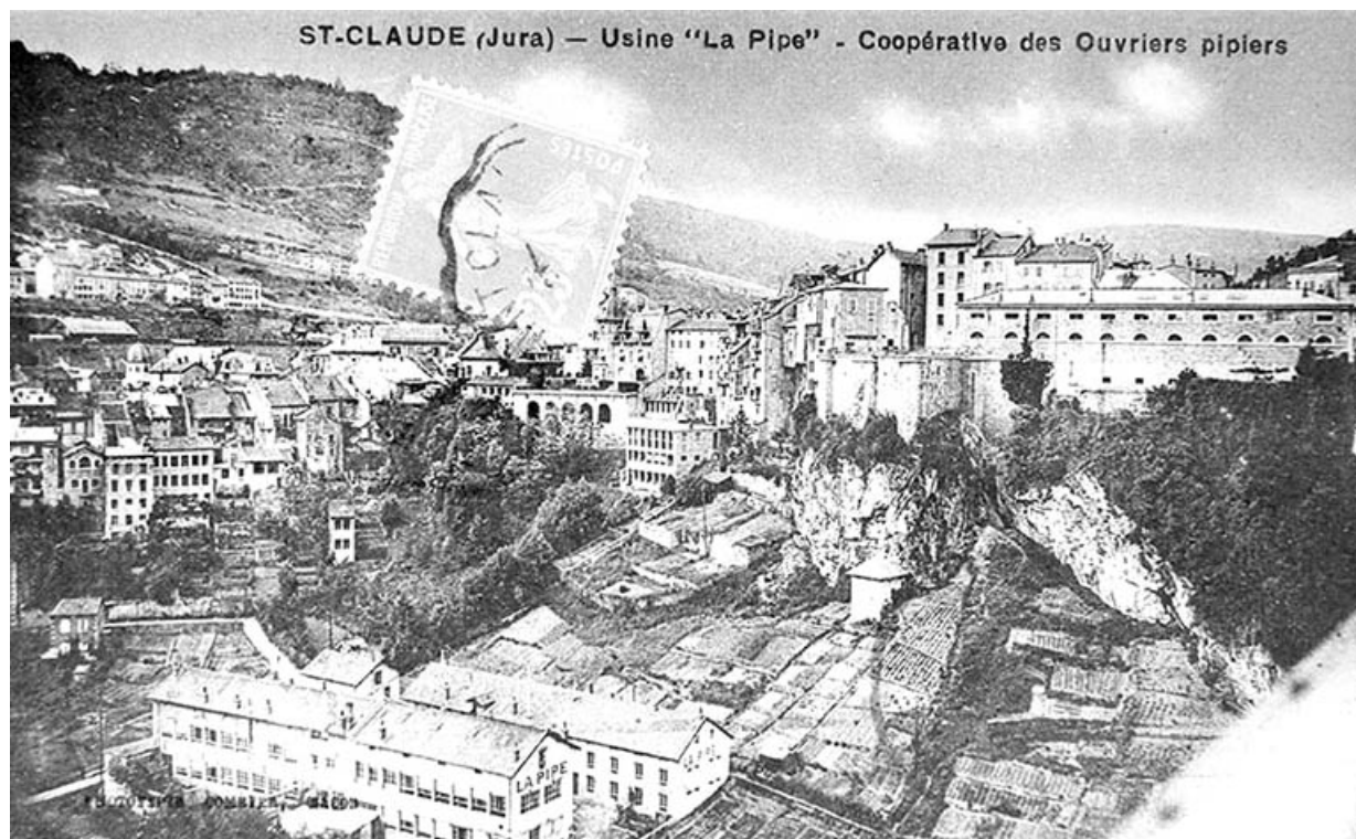
St-Claude (Jura) - Usine "La Pipe" - Coopérative des Ouvriers pipiers.
