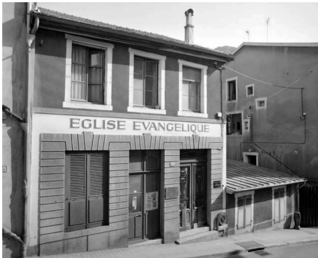
Façade antérieure du bâtiment rue de la Poyat.
