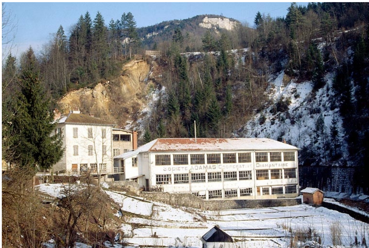
Vue d'ensemble depuis l'ouest, en hiver.
