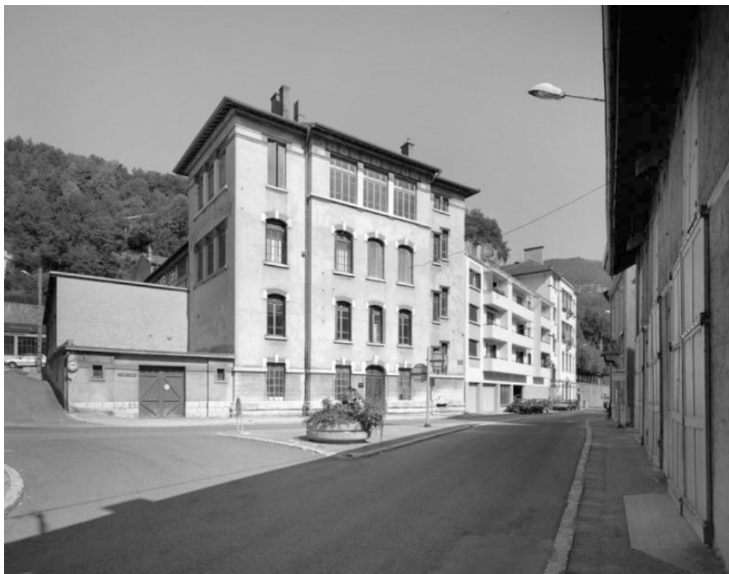
Vue d'ensemble des façades sur la route de Genève.
