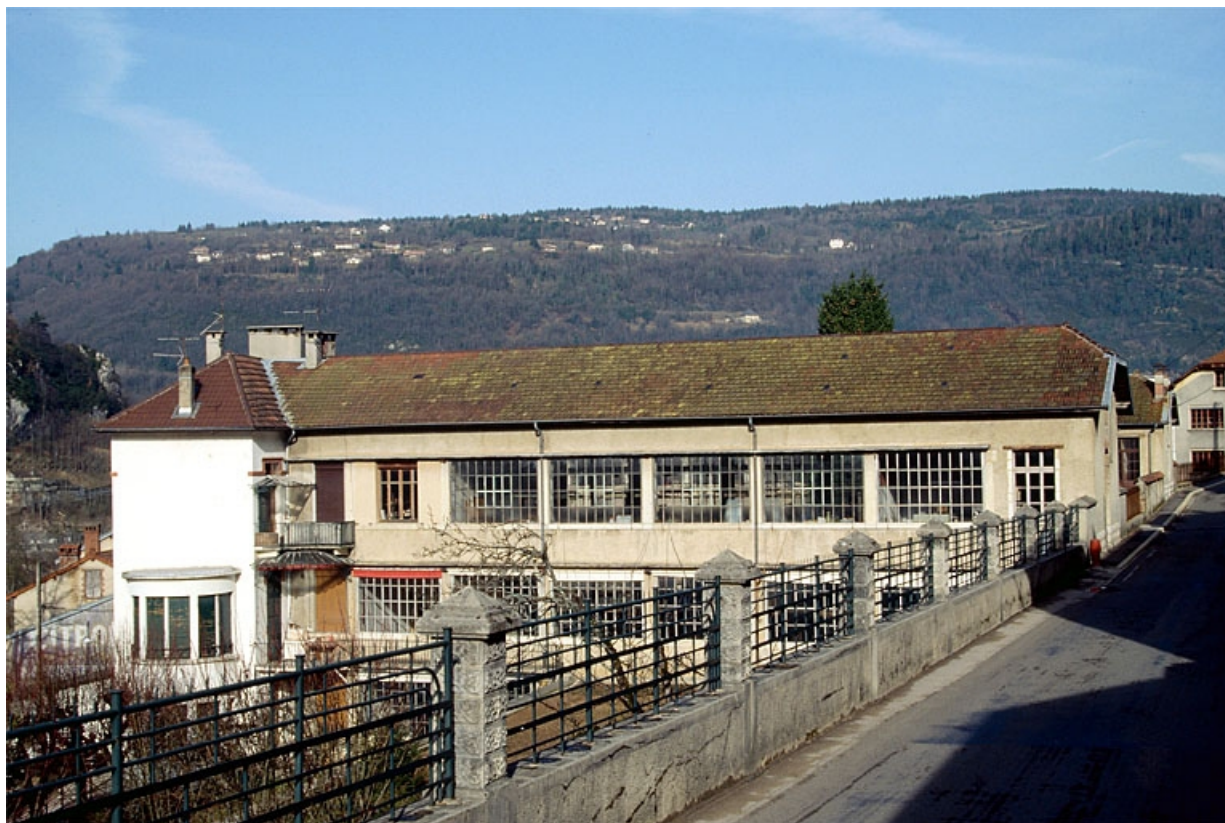
Façade latérale droite du 2e bâtiment.
