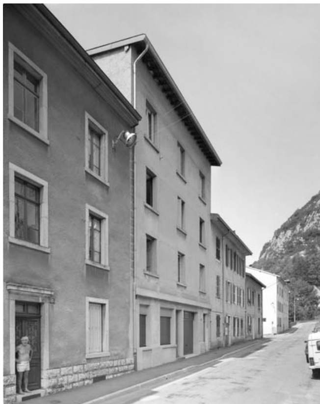
Façade antérieure de l'immeuble aux 11-11 bis, rue Lançon. 39, Saint-Claude, 24, 26 route de Genève, lieudit : Saint-Hubert
