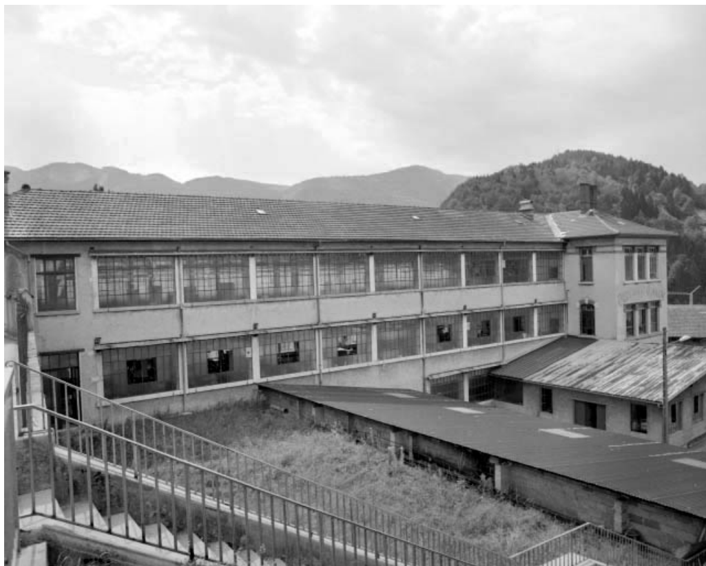
Façade latérale gauche du 1er bâtiment.
