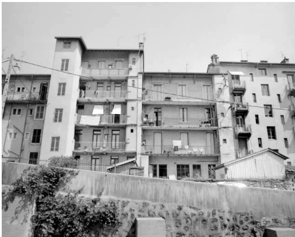
Façade postérieure des immeubles de la rue Lançon.
