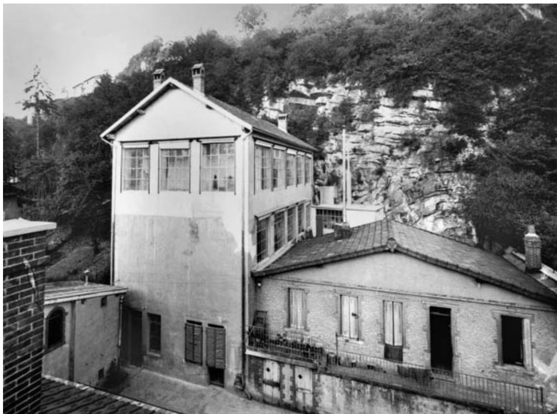
Façade antérieure, milieu 20e siècle.
