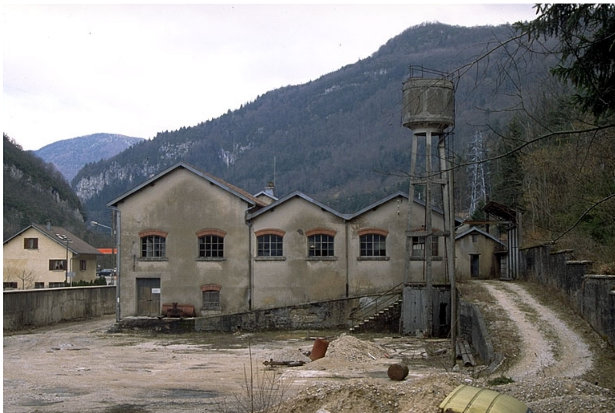
Cour, atelier de fabrication et château d'eau.
