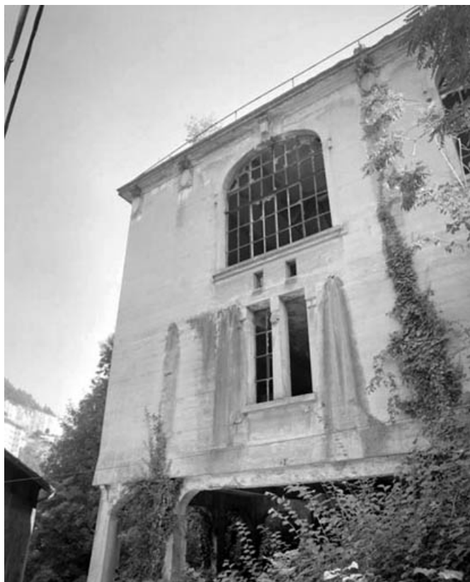
Façade latérale gauche du transformateur : une travée.
