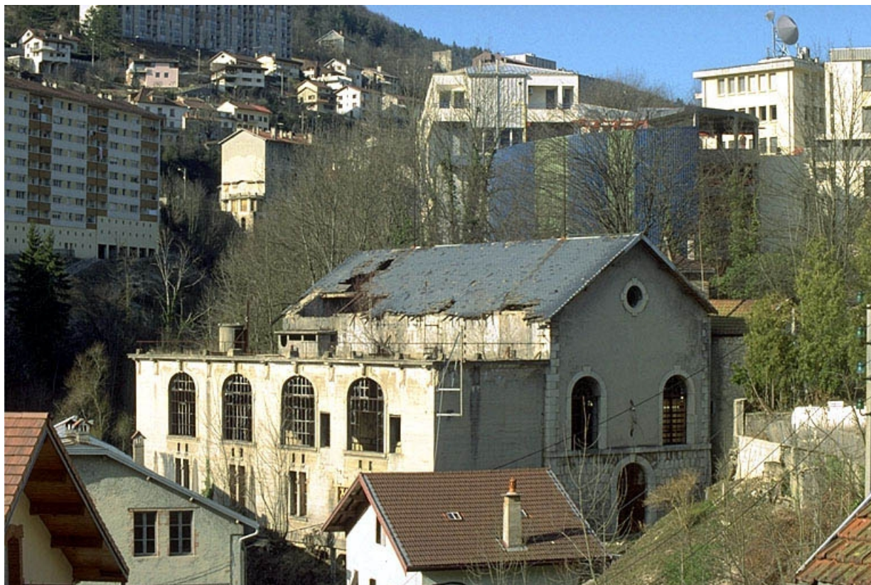
Vue d'ensemble rapprochée depuis le sud.
