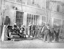
Filling reservoir with town fire pump [Remplissage du réservoir avec la pompe à incendie de la ville en 1910].
