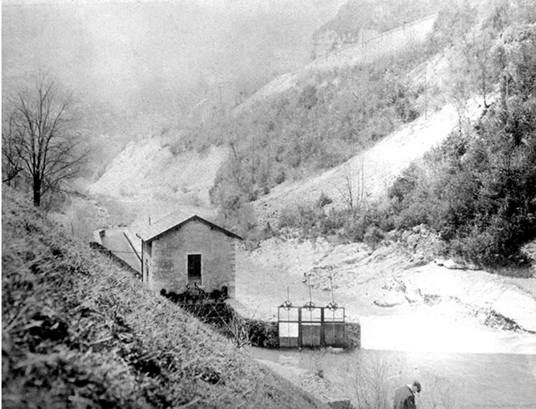
Turbine House & Dam [Bâtiment d'eau et barrage en 1910].
