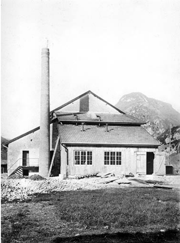
Producer House, annexe and Chimney [Atelier de fabrication, annexe et cheminée en 1910]. 39, Saint-Claude, 11, 26, 28, 32, 34 rue Saint-Blaise
