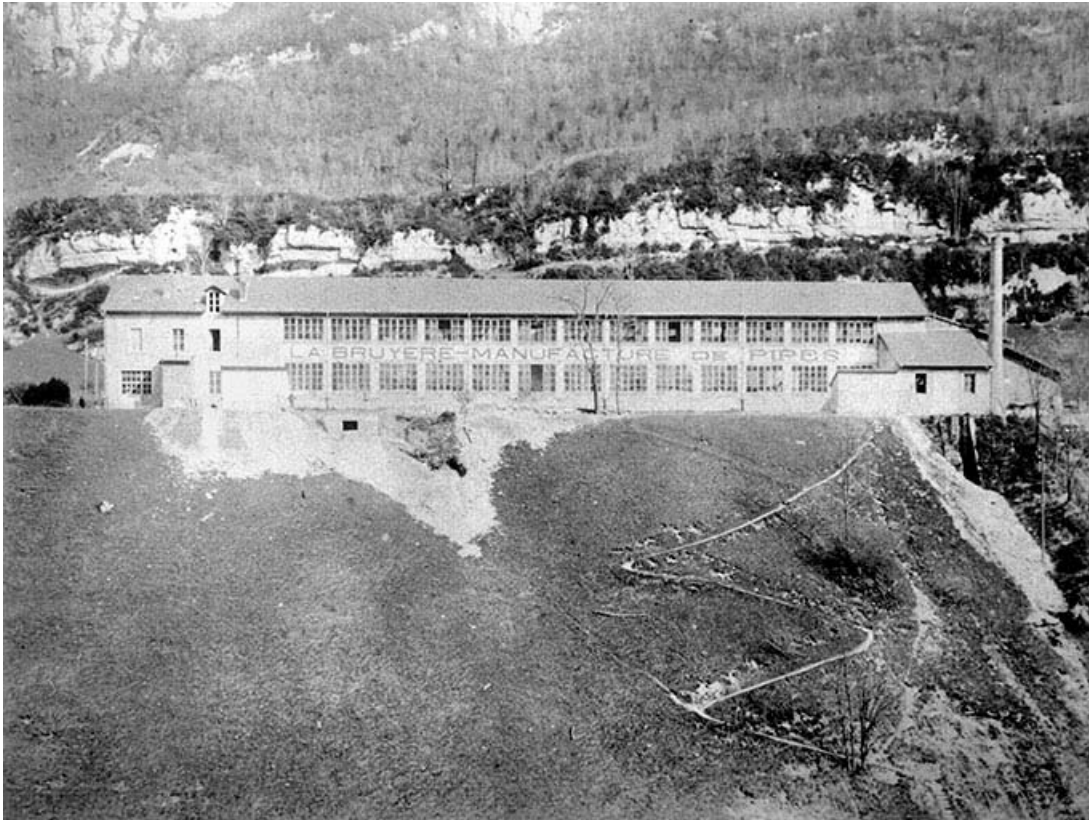
St Blaise Factory. Side facing River [Usine de Saint-Blaise. Façade du côté de la rivière en 1910].
