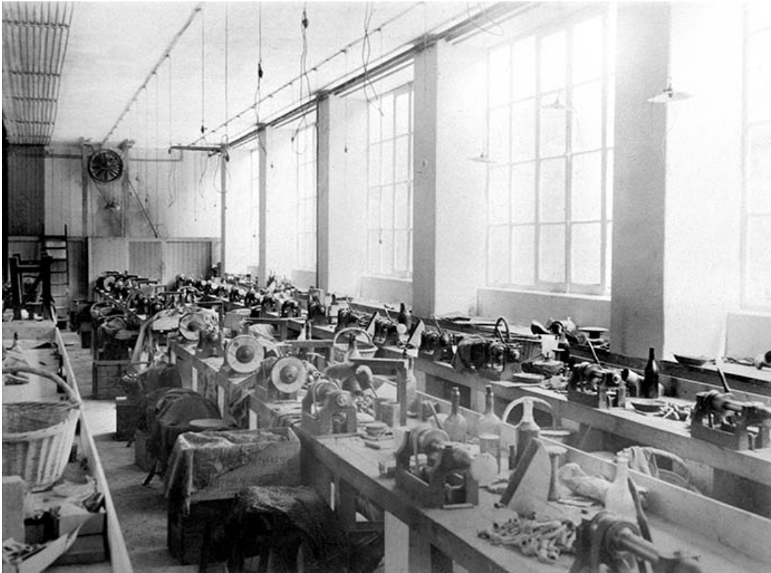
Ground Floor. Polissage [Rez-de-chaussée. Polissage en 1910].
