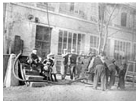
Filling reservoir with town fire pump [Remplissage du réservoir avec la pompe à incendie de la ville en 1910].
