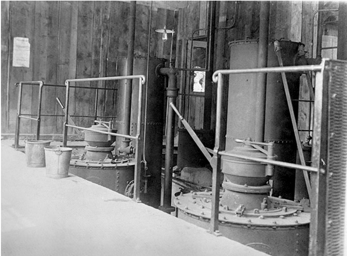
Suction Gas Producers [Gazogène à aspiration en 1910].
