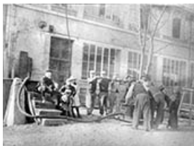
Filling reservoir with town fire pump [Remplissage du réservoir avec la pompe à incendie de la ville en 1910].
