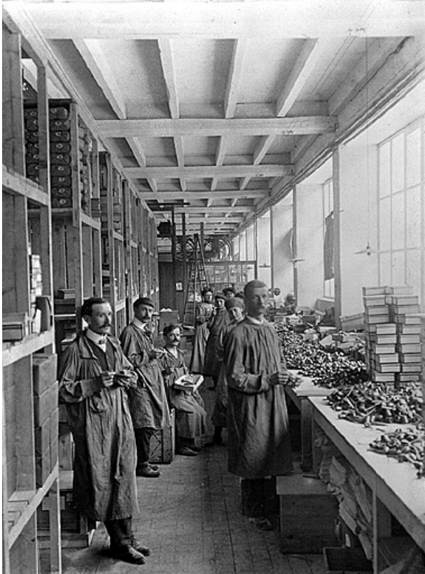
First Floor. Warehouse [Premier étage. Magasin industriel en 1910].
