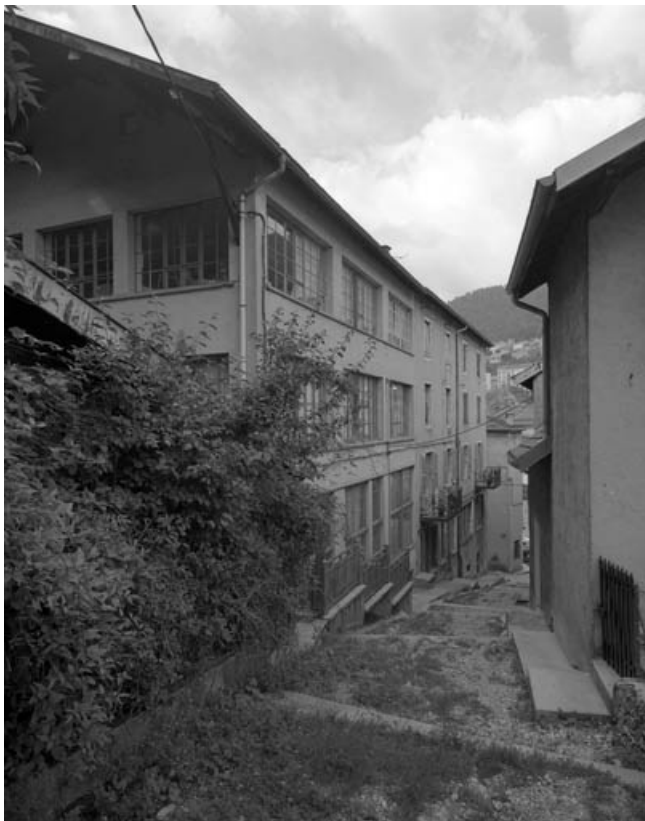
Façades sur la rue des Petites Etapes, de trois quarts droite.
