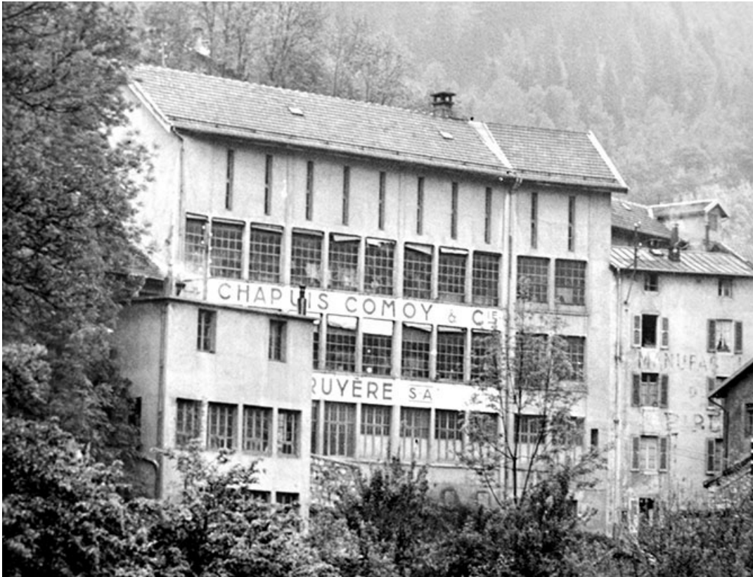
[Façades sur la rue des Etapes].
