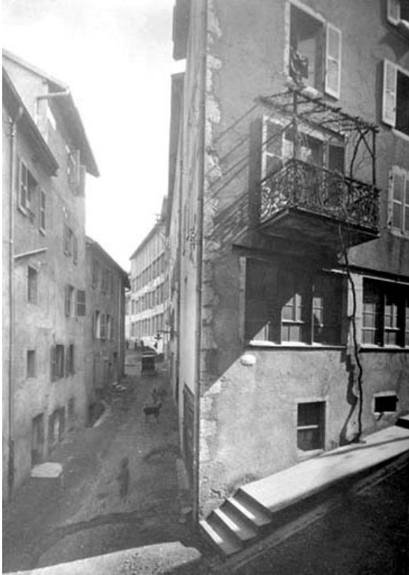
Façades à l'angle de la rue des Etapes et de celle des Petites Etapes, en 1926. 39, Saint-Claude, 2, 4 rue des Etapes
