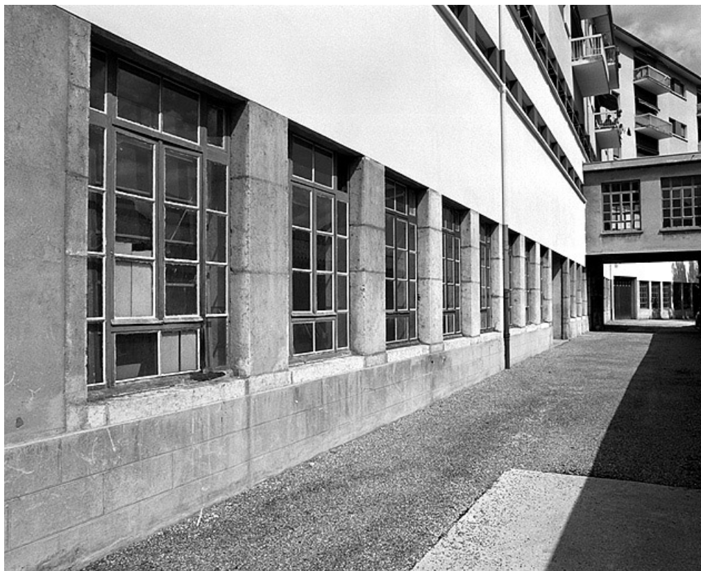
Façade postérieure : baies du 2e étage de soubassement.
