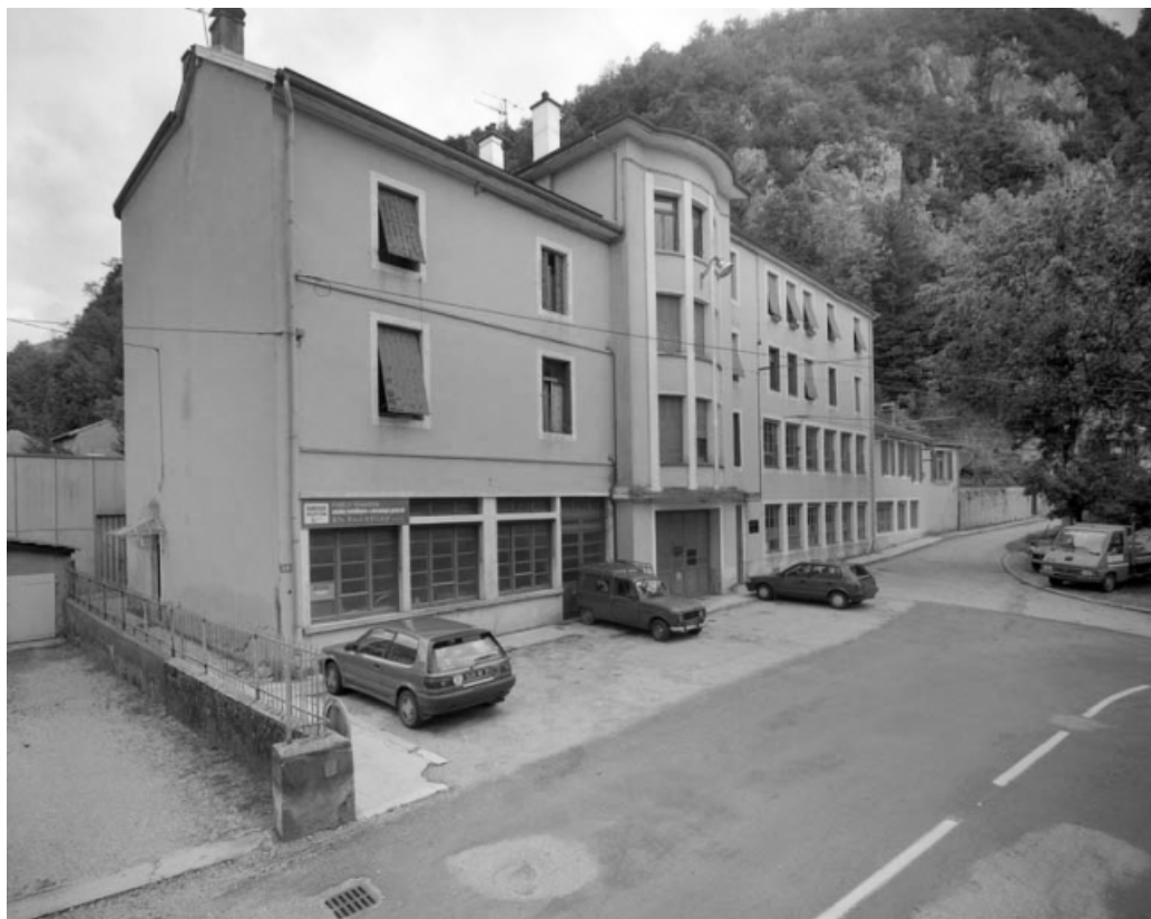
Façade antérieure de trois quarts gauche. 39, Saint-Claude, 6, 8, 10 rue Edouard Branly
