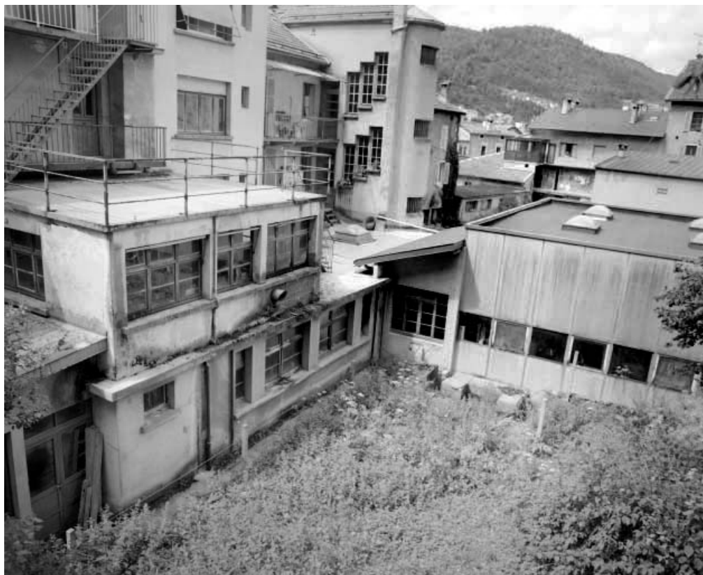
Ateliers de fabrication. Atelier de 1967 à droite.
