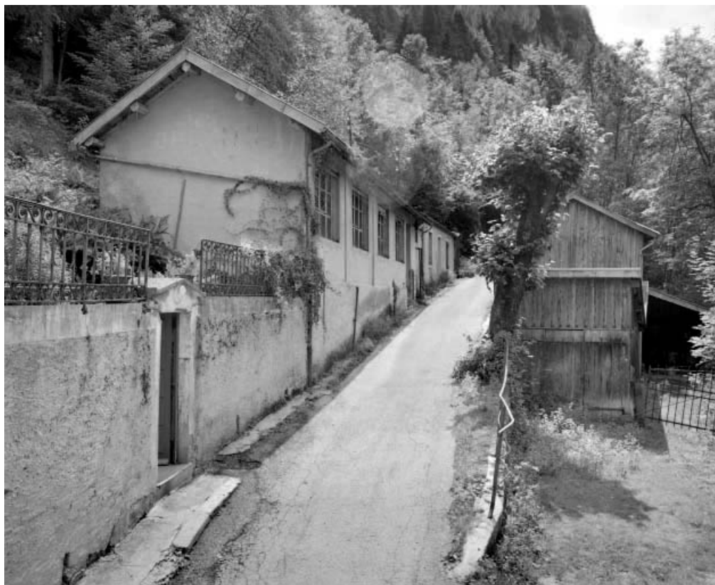
Ateliers désaffectés, hangar et remise. Inscription Orolith sur la mur pignon à gauche. 39, Saint-Claude, 6, 8, 10 rue Edouard Branly
