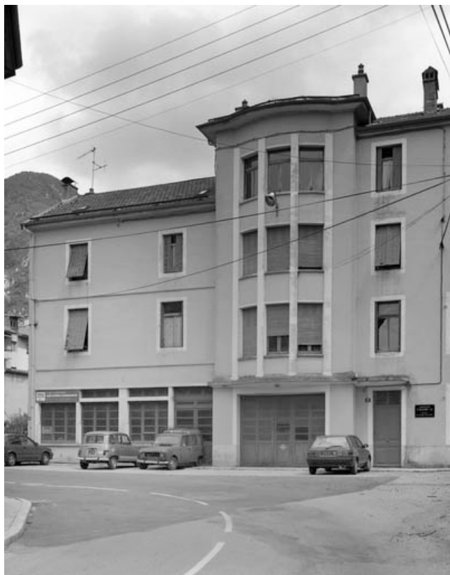
Extrémité nord de la façade antérieure.
