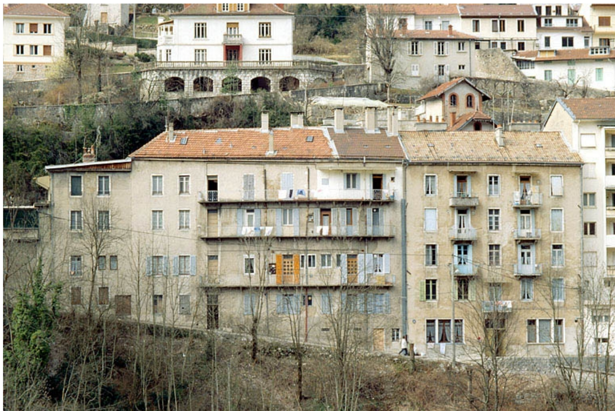
Façade postérieure des immeubles n° 22 et 24.
