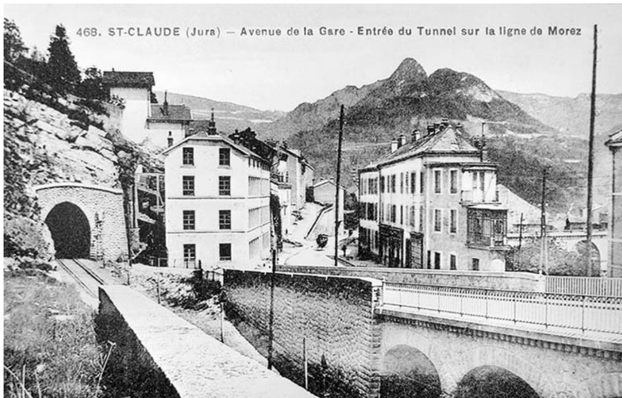
St-Claude (Jura) - Avenue de la Gare. Entrée du tunnel sur la ligne de Morez.
