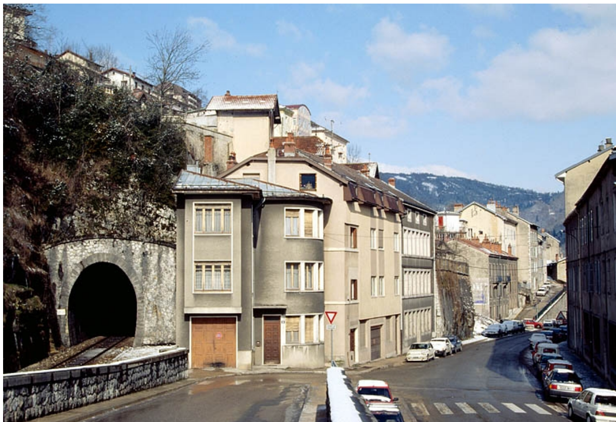
Vue d'ensemble des bâtiments n° 23 et 25 (ateliers de fabrication). 39, Saint-Claude, 22 à 25 avenue de la Gare
