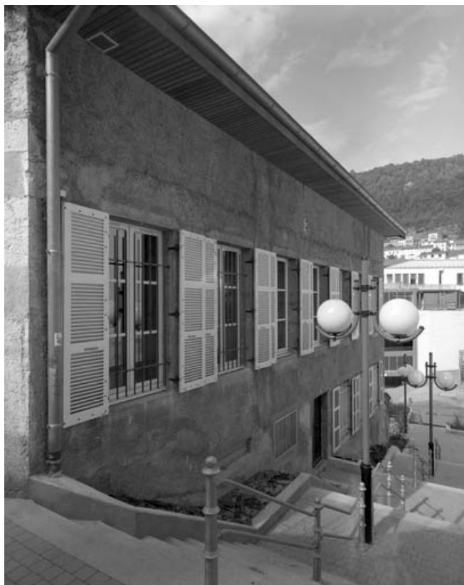
Bâtiment des bureaux vu de trois quarts gauche.
