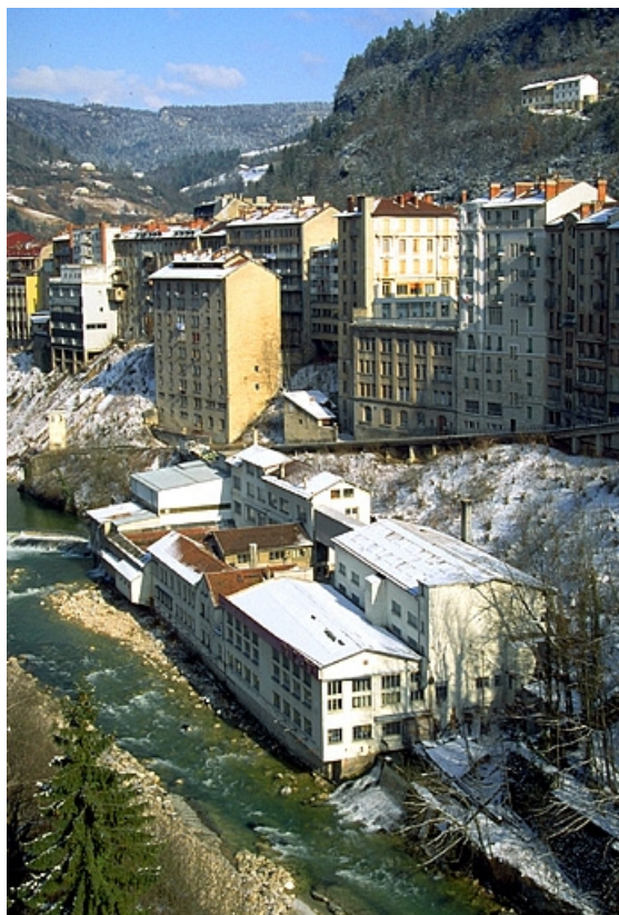
Vue plongeante depuis le sud-ouest.
