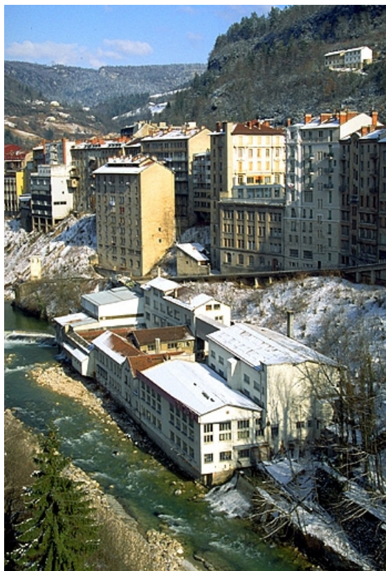
Vue plongeante depuis le sud-ouest.
