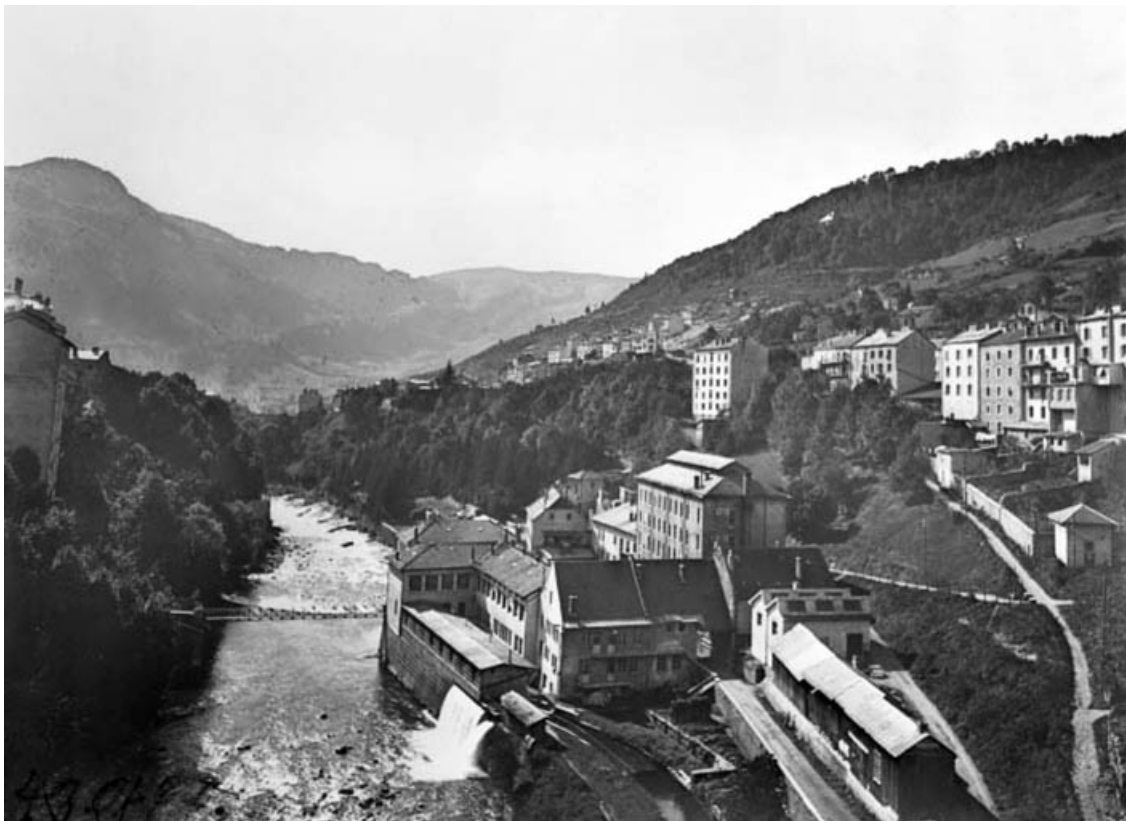
[Vue d'ensemble de l'usine depuis le Pont de pierre].
