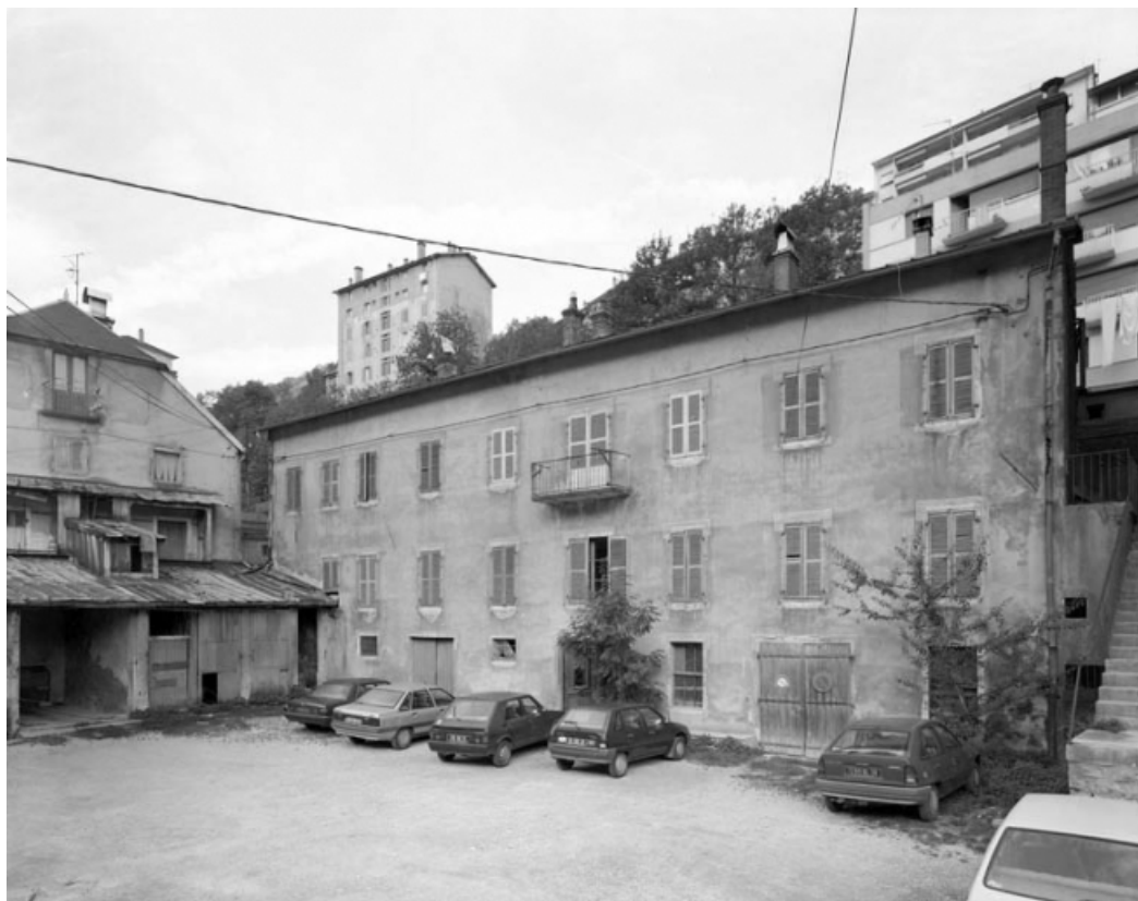
Internat de l'école de formation Dalloz : façade antérieure.
