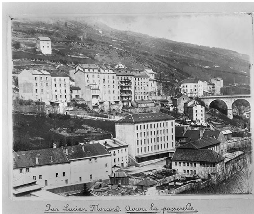
Vue d'ensemble du quartier et de l'usine avant la construction de la passerelle.
