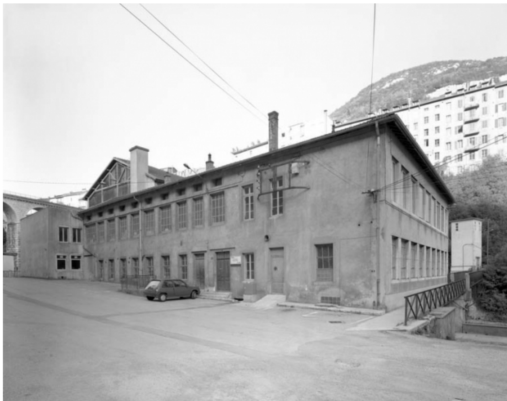
Diamanterie Dalloz (actuelle usine Tacchini) : façades antérieure et latérale droite. 39, Saint-Claude, 1 à 23 rue de la Papeterie
