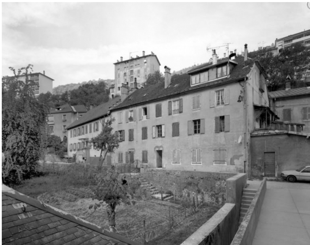
Logement d'ouvriers et logement patronal Dalloz : façade antérieure de trois quarts droite. 39, Saint-Claude, 1 à 23 rue de la Papeterie
