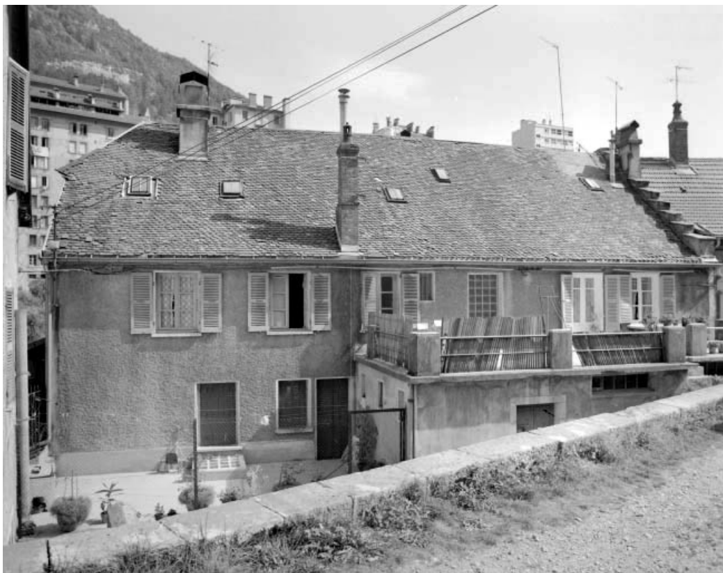
Logement d'ouvriers Dalloz : façade postérieure.
