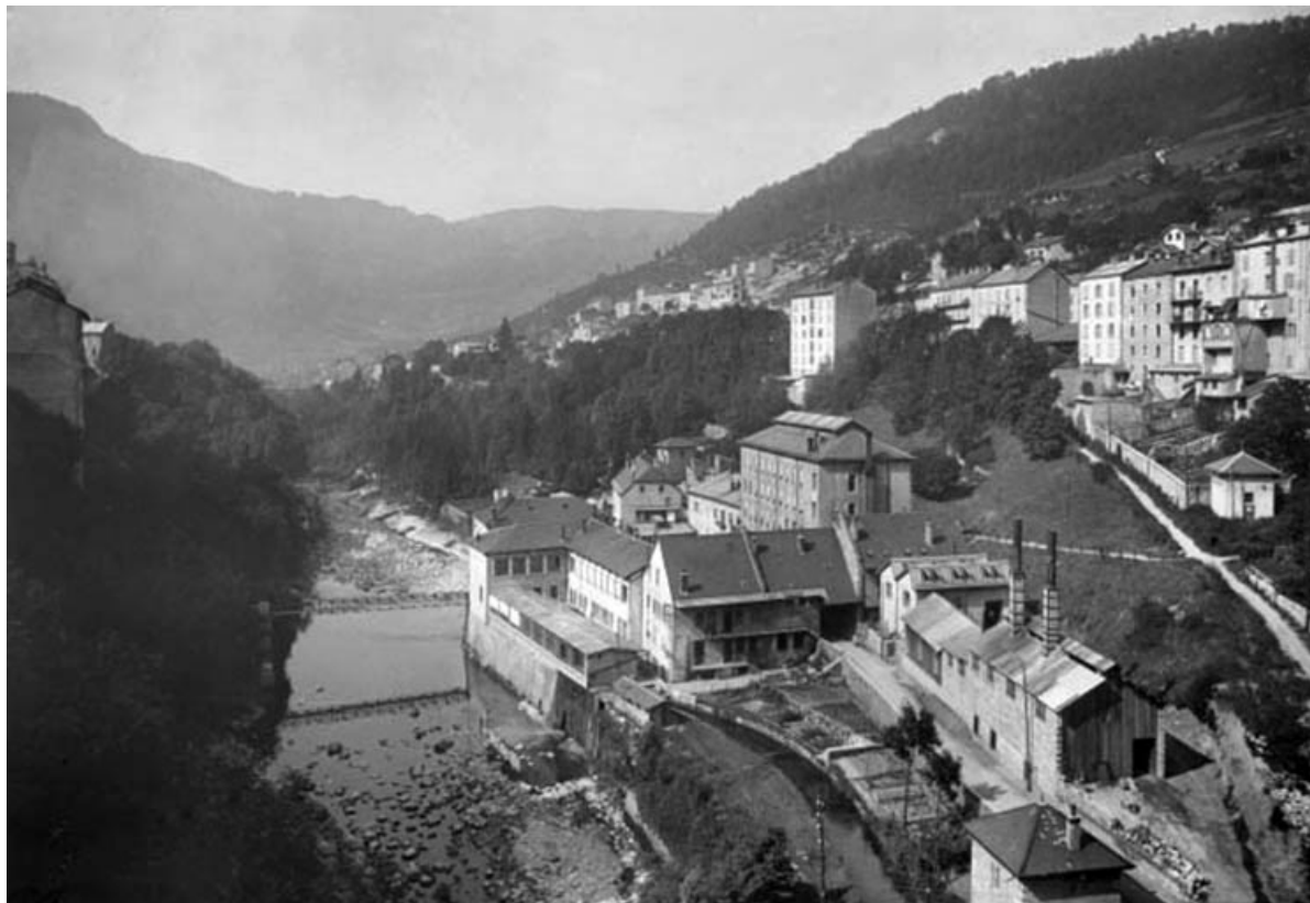
[Vue d'ensemble de l'usine depuis le Pont de pierre].
