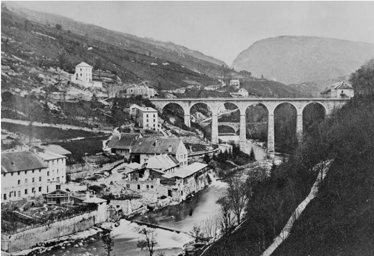
[Vue d'ensemble de l'usine et du Pont de pierre depuis le sud-est].
