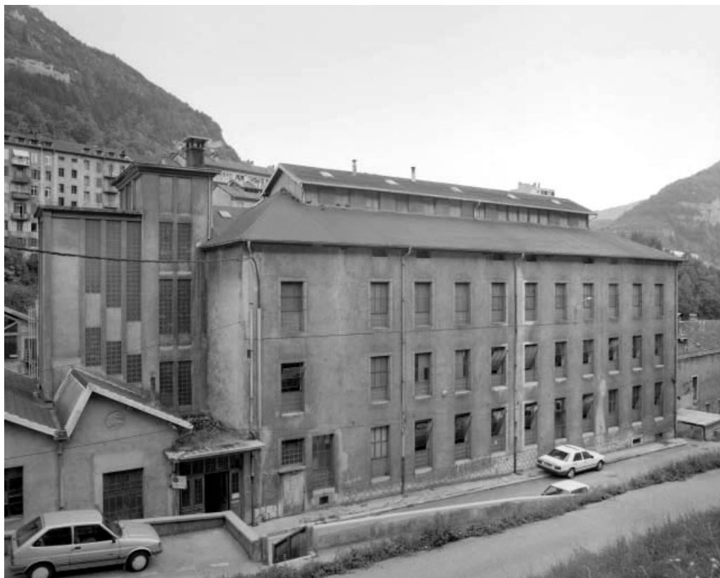
Taillerie Dalloz : façade antérieure de trois quarts gauche.
