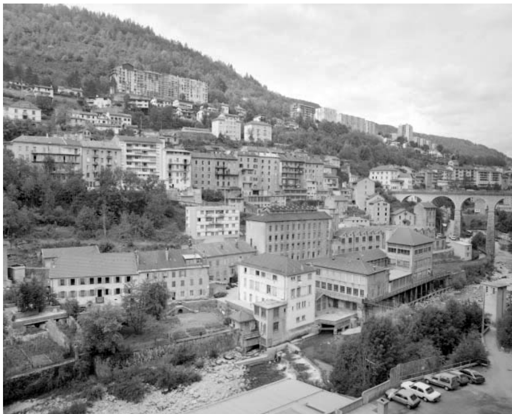
Vue d'ensemble de l'usine et des logements anciens, depuis le sud-est.
