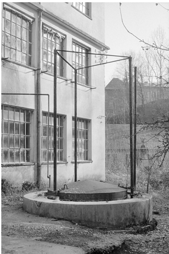
Gazomètre (stockage d'acétylène).
