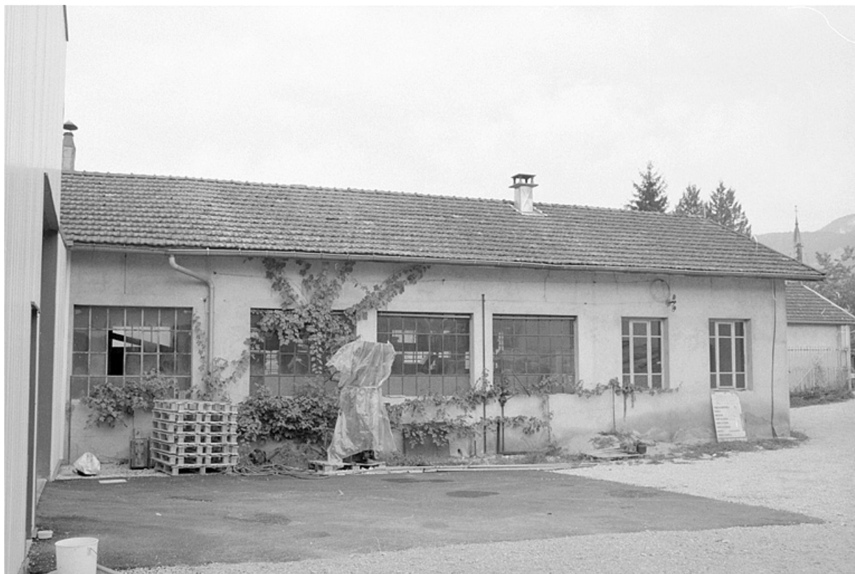
Anciens bureaux et atelier de la presse Reed Prentice.
