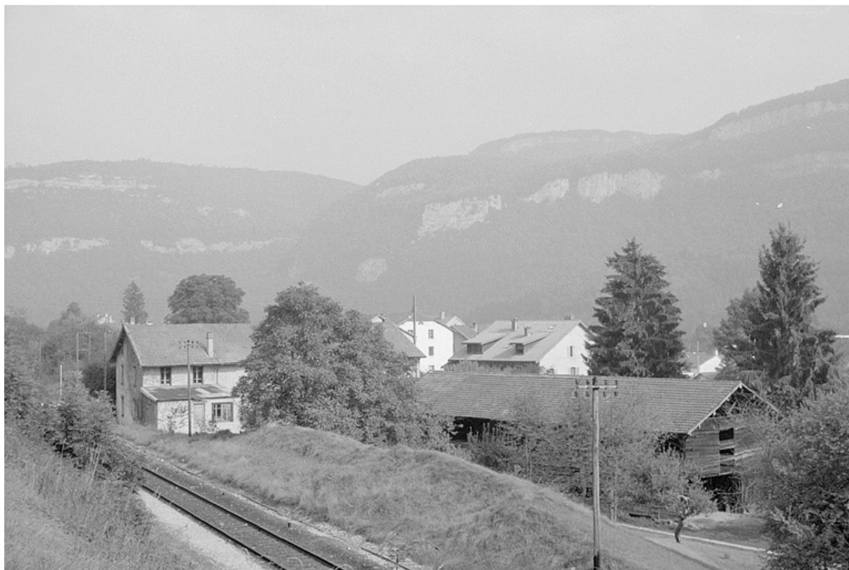
Vue d'ensemble depuis le sud.
