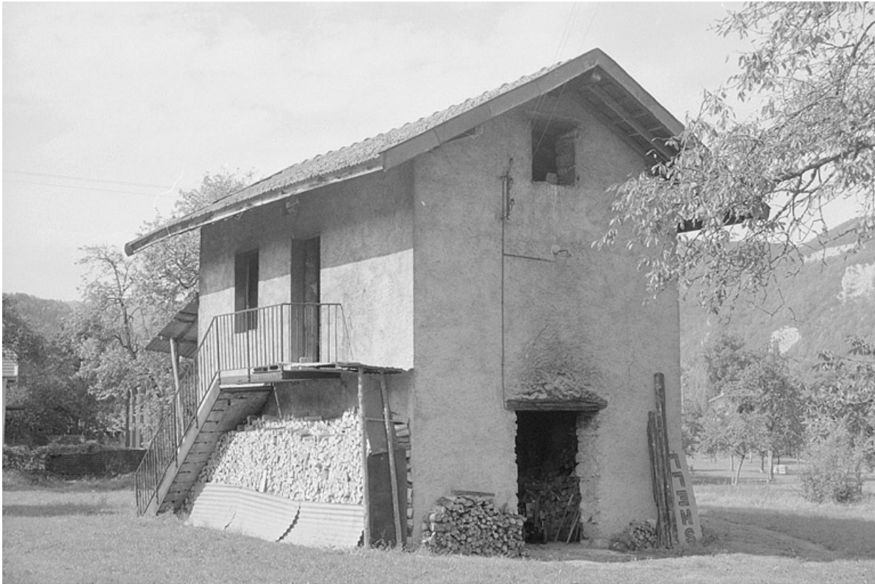
Bâtiment du four et du logement d'ouvriers.
