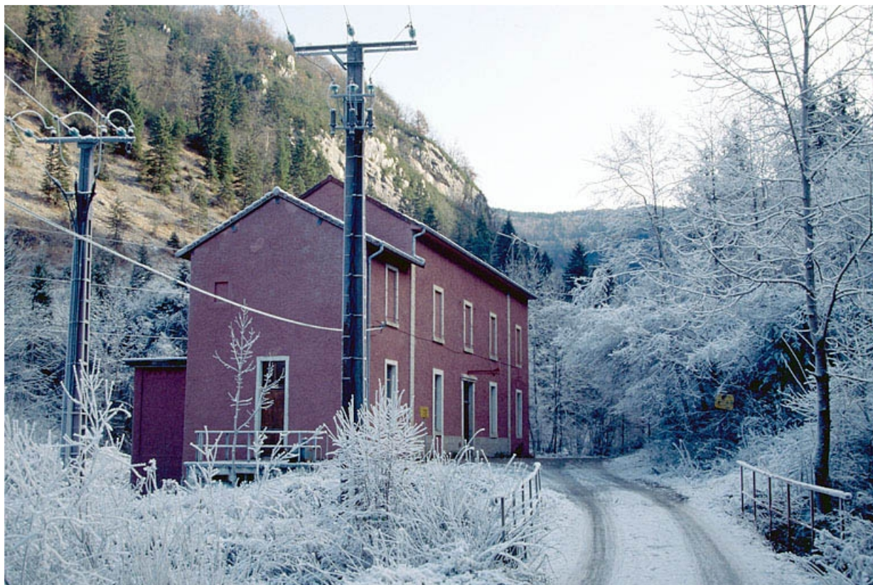
Façade antérieure et latérale gauche.
