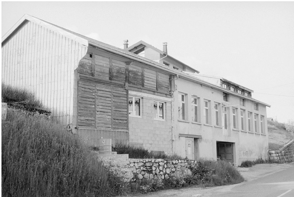
Atelier de mécanique (ancienne fabrique de meubles Julliard).
