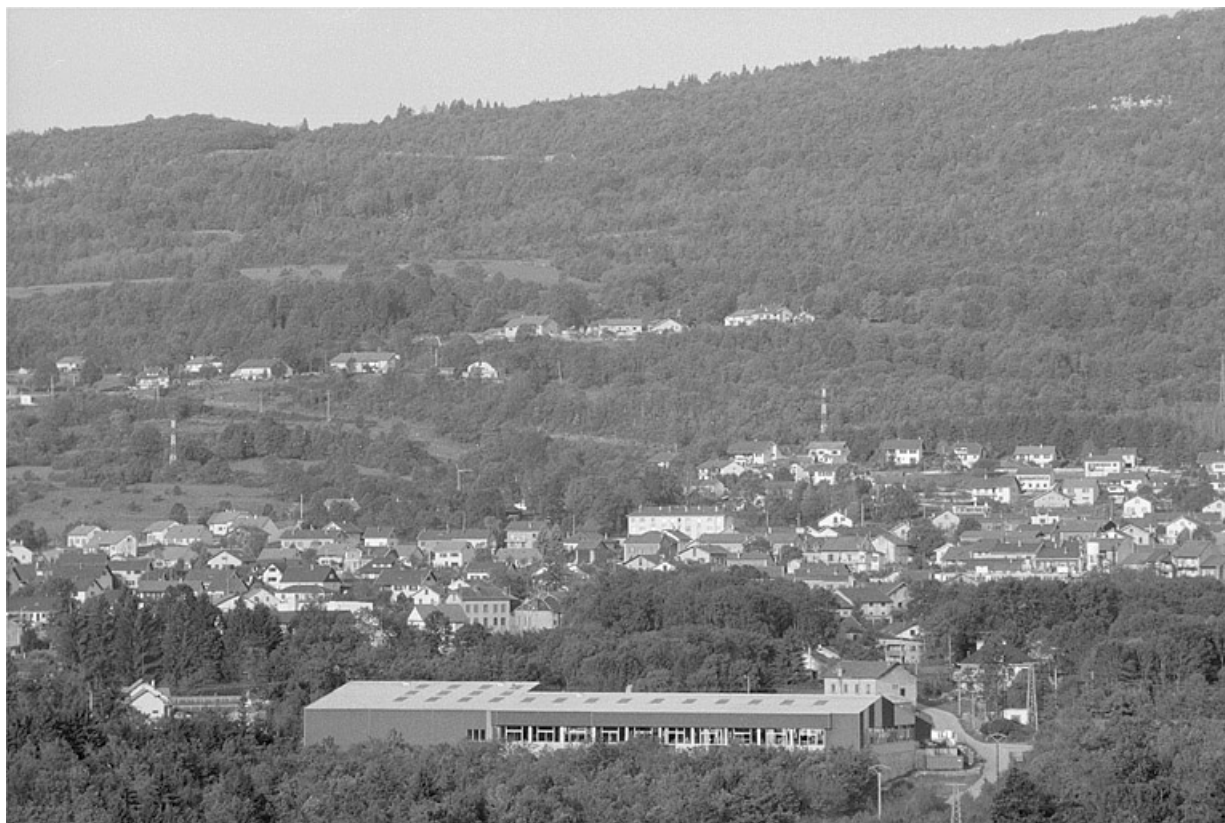
Vue d'ensemble de la nouvelle usine, depuis l'est.
