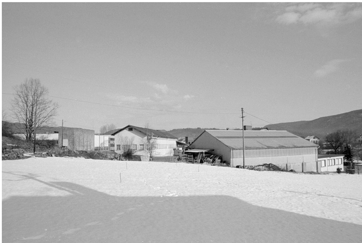
Vue d'ensemble des bâtiments (P, T).
