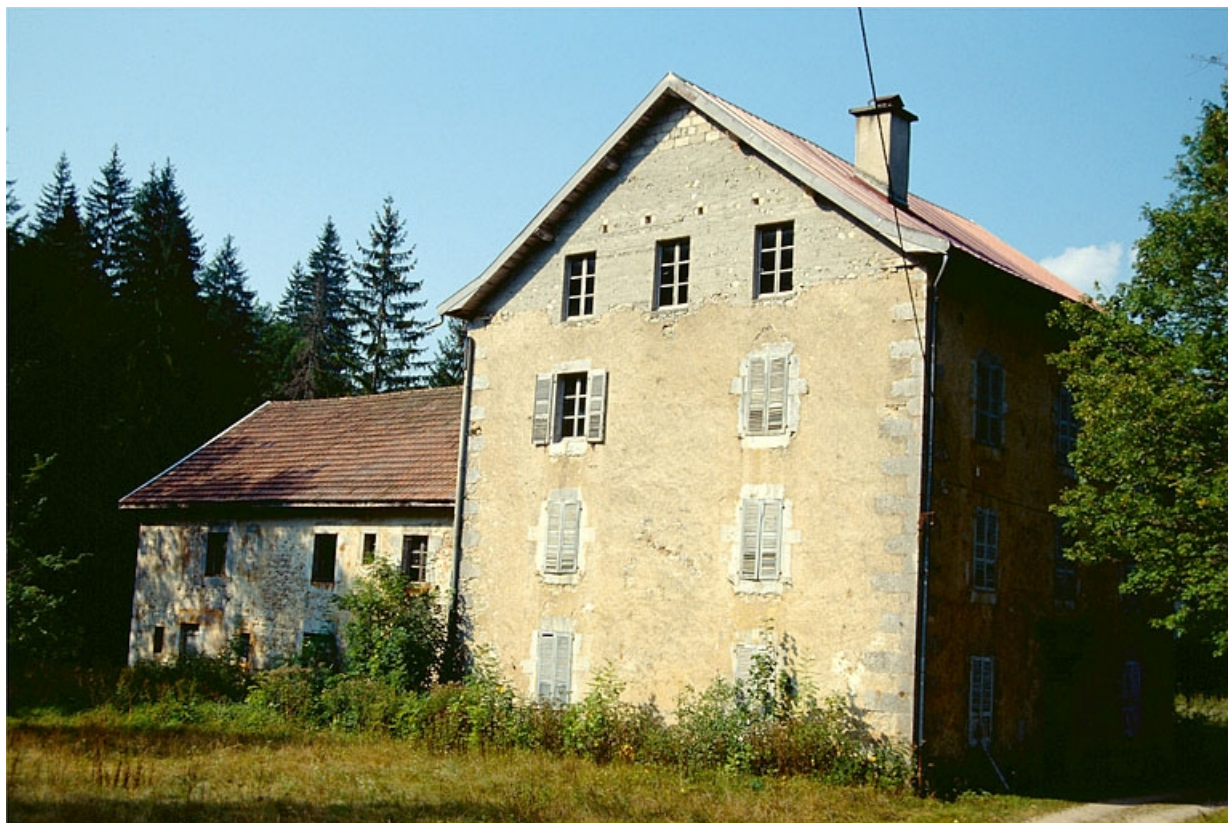
Logement et atelier de fabrication (B, C). 39, La Rixouse, lieudit : sous Roche Blanche
