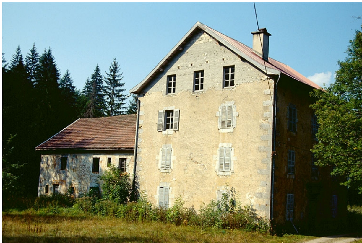
Logement et atelier de fabrication (B, C). 39, La Rixouse, lieudit : sous Roche Blanche
