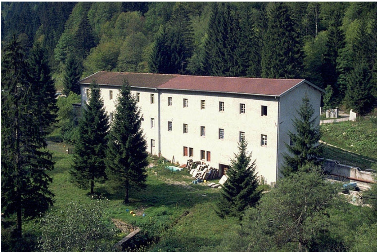
Vue d'ensemble depuis l'est (façade postérieure).
