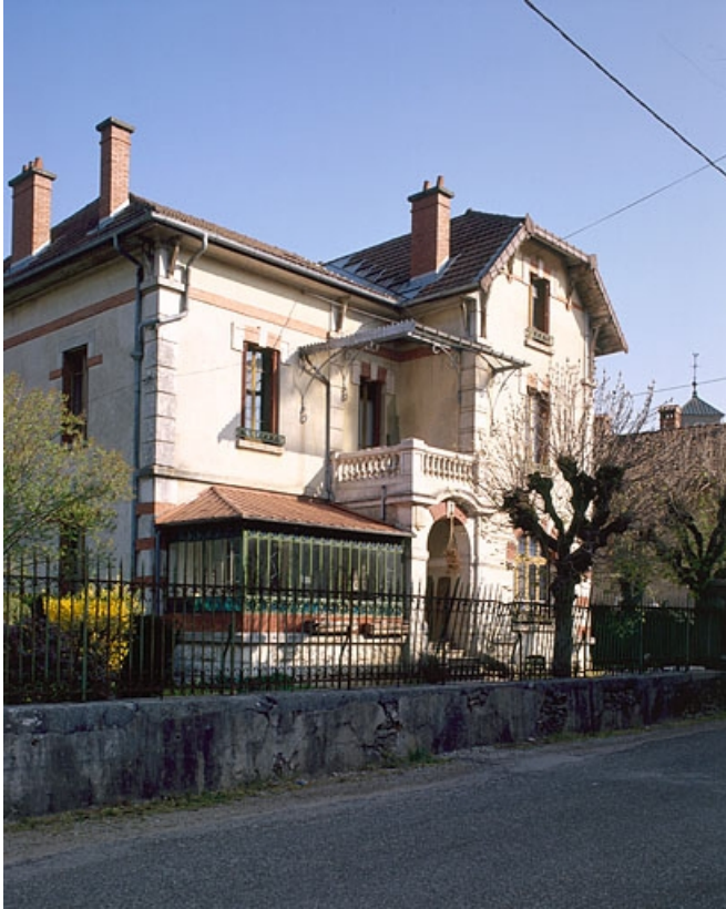
Vue d'ensemble de la façade antérieure, de trois quarts gauche. 39, Molinges
