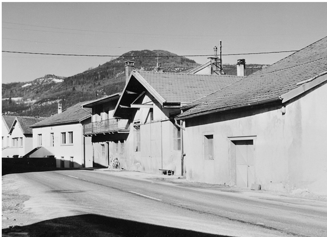
Façade antérieure des ateliers entre la route et la Bienne.
