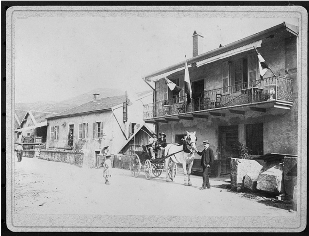
Attelage devant des ateliers et logement.
