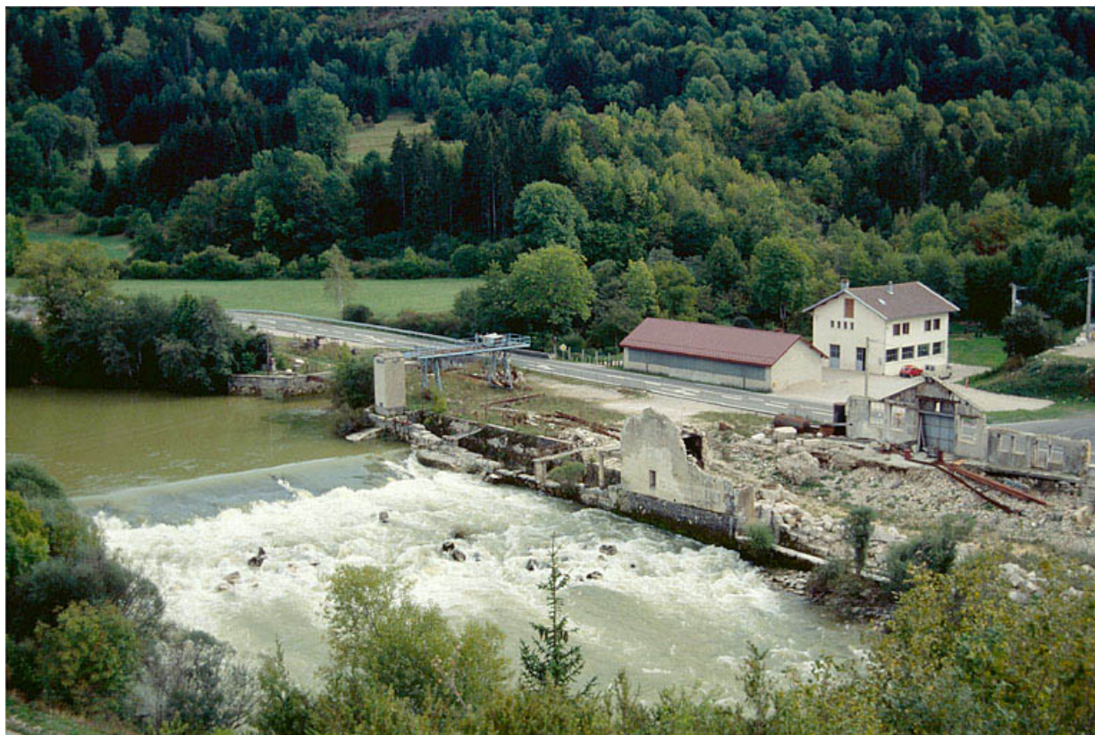
Vue d'ensemble plongeante depuis le nord.
