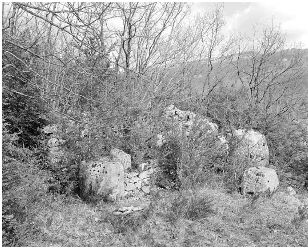
Carrière de Marignat, commune de Chassal : ruines de la forge (et entrepôt d'outils). 39, Molinges
