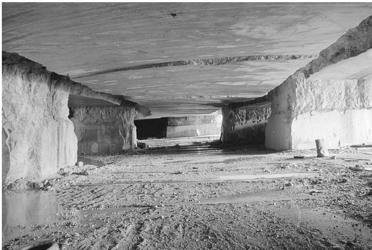
Carrière souterraine de Chassal : galerie latérale. 39, Molinges
