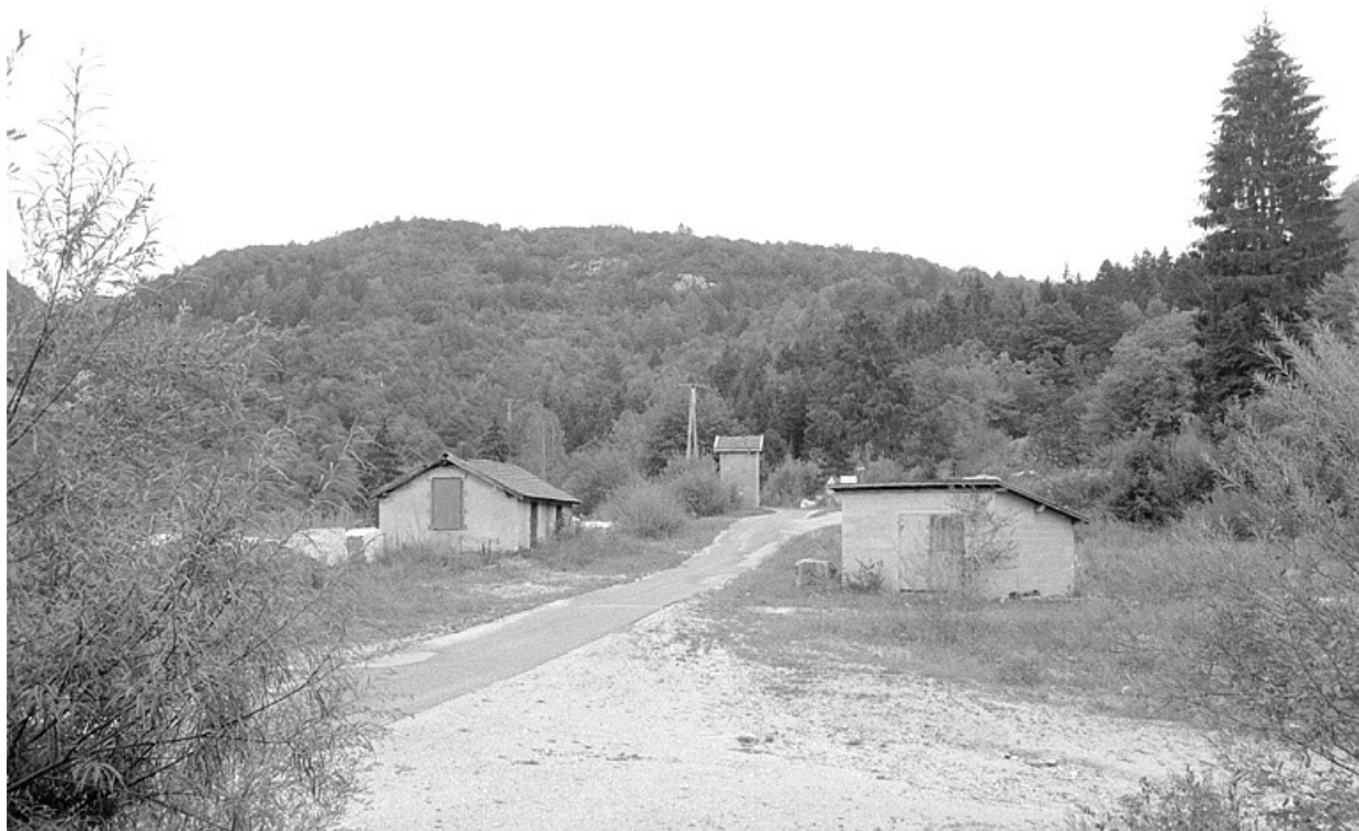
Carrière souterraine de Chassal : bâtiments. La carrière souterraine est à droite. 39, Molinges
