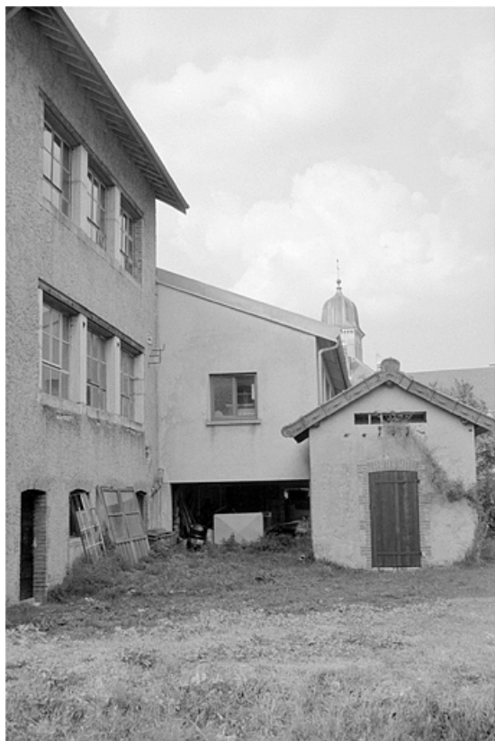
Façade postérieure et transformateur.
