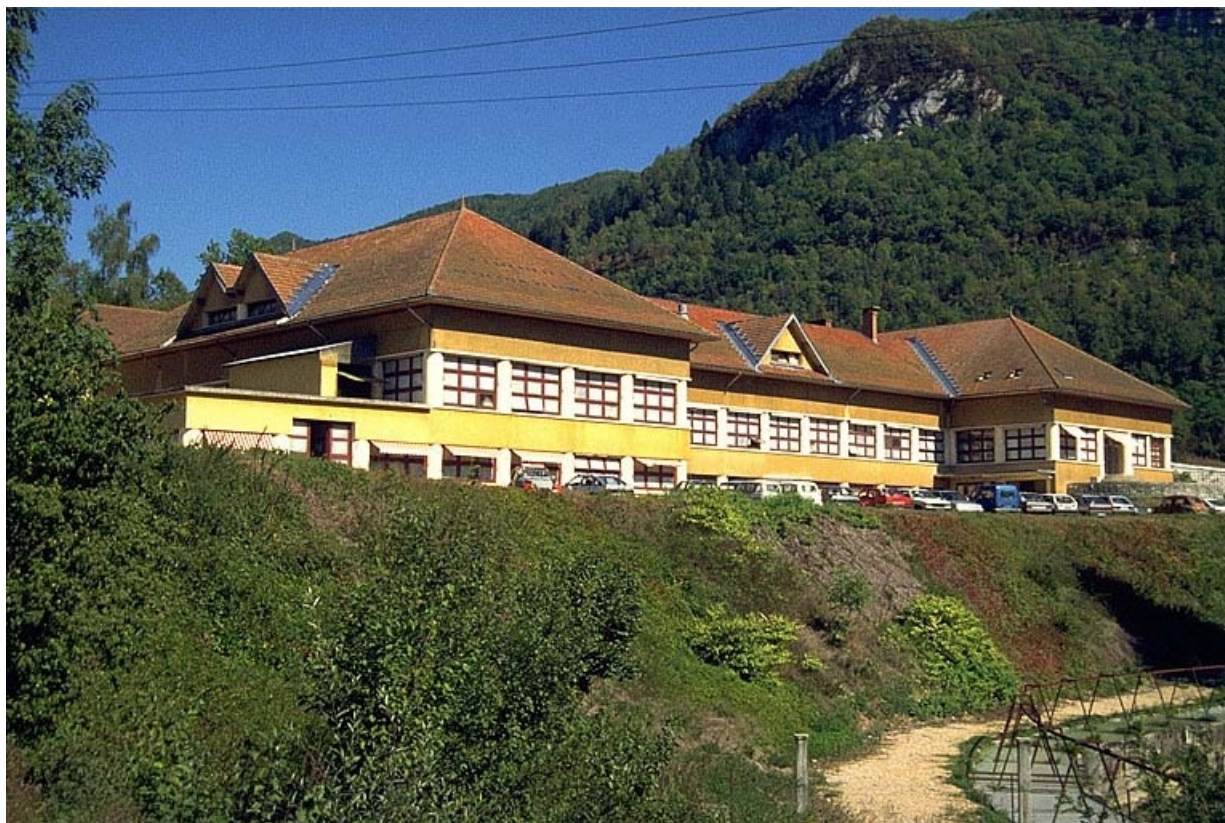
Nouvelle usine, vue depuis le sud-ouest. Bassin de décantation à droite.
