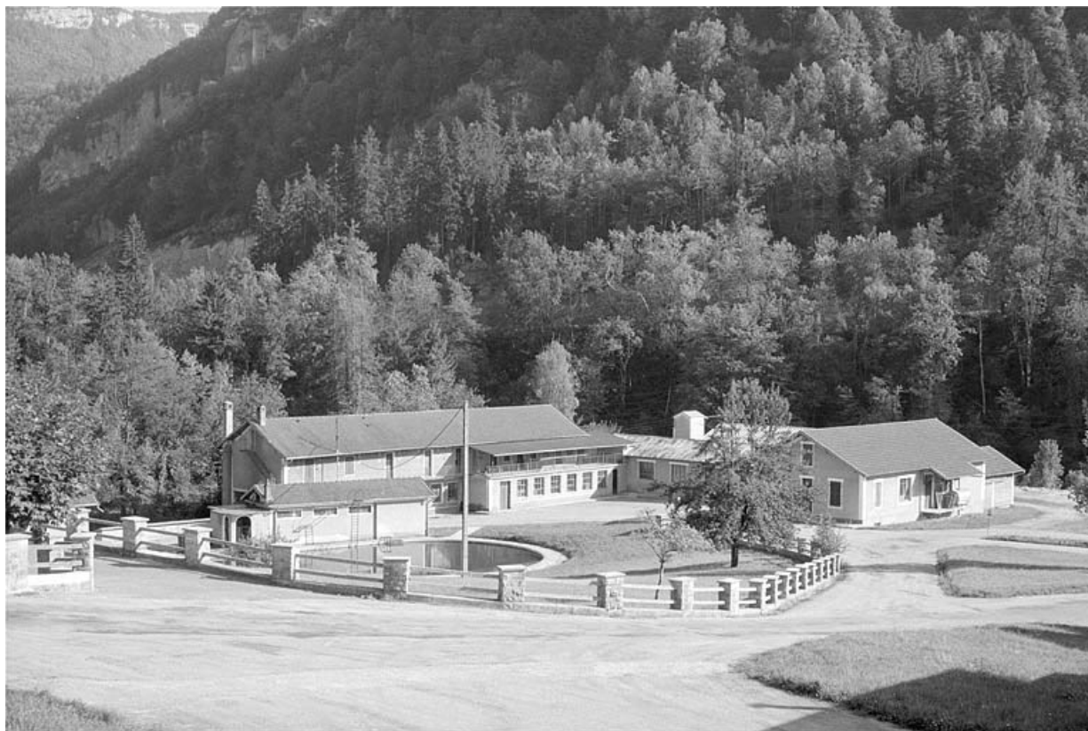
Ancienne usine, vue depuis le nord-ouest.
