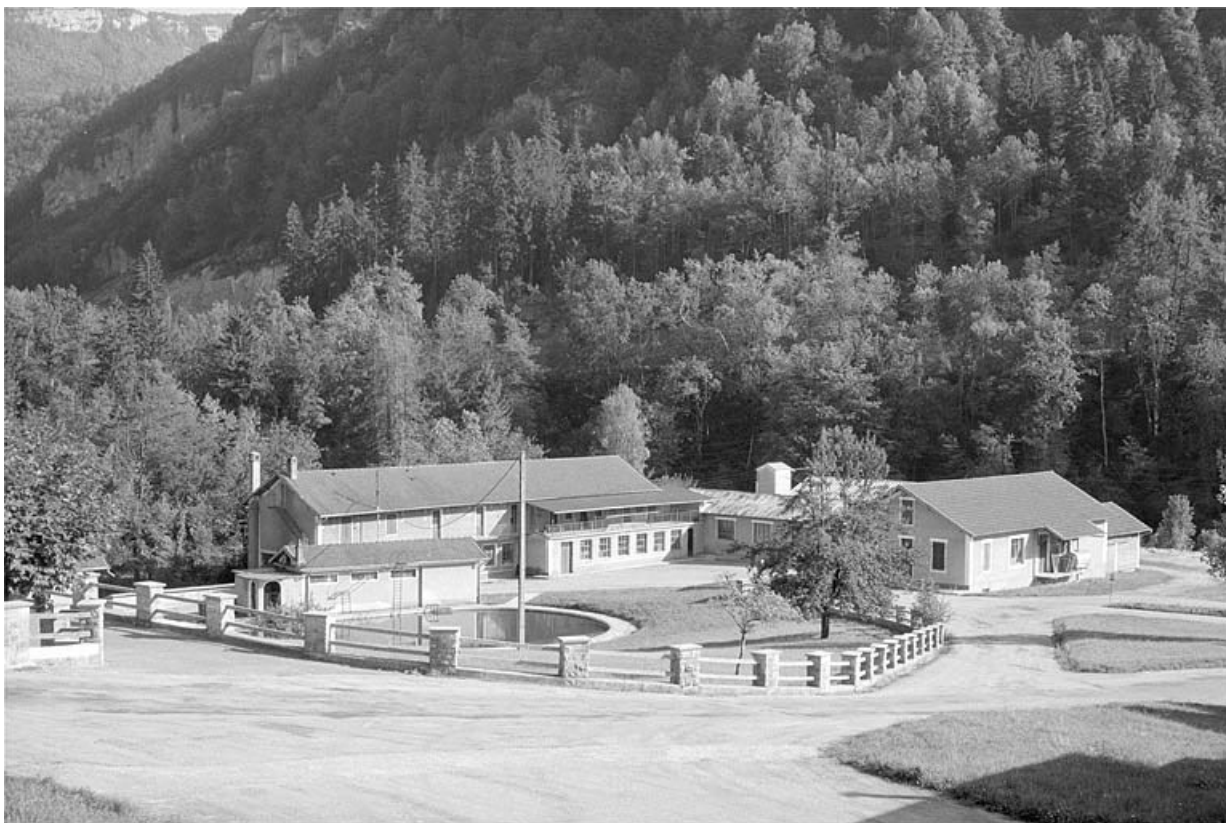
Ancienne usine, vue depuis le nord-ouest.
