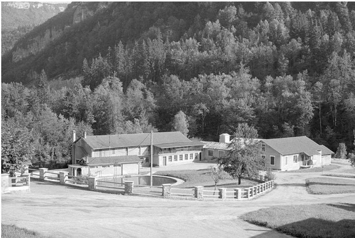
Ancienne usine, vue depuis le nord-ouest.
