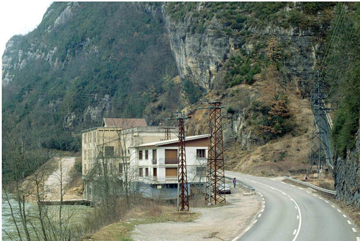
Vue d'ensemble : logement d'ouvriers et centrale.
