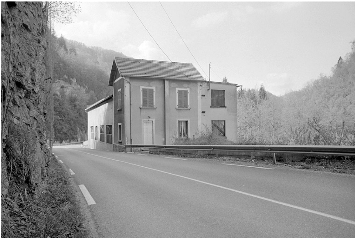
Façades postérieure et latérale droite de la centrale.
