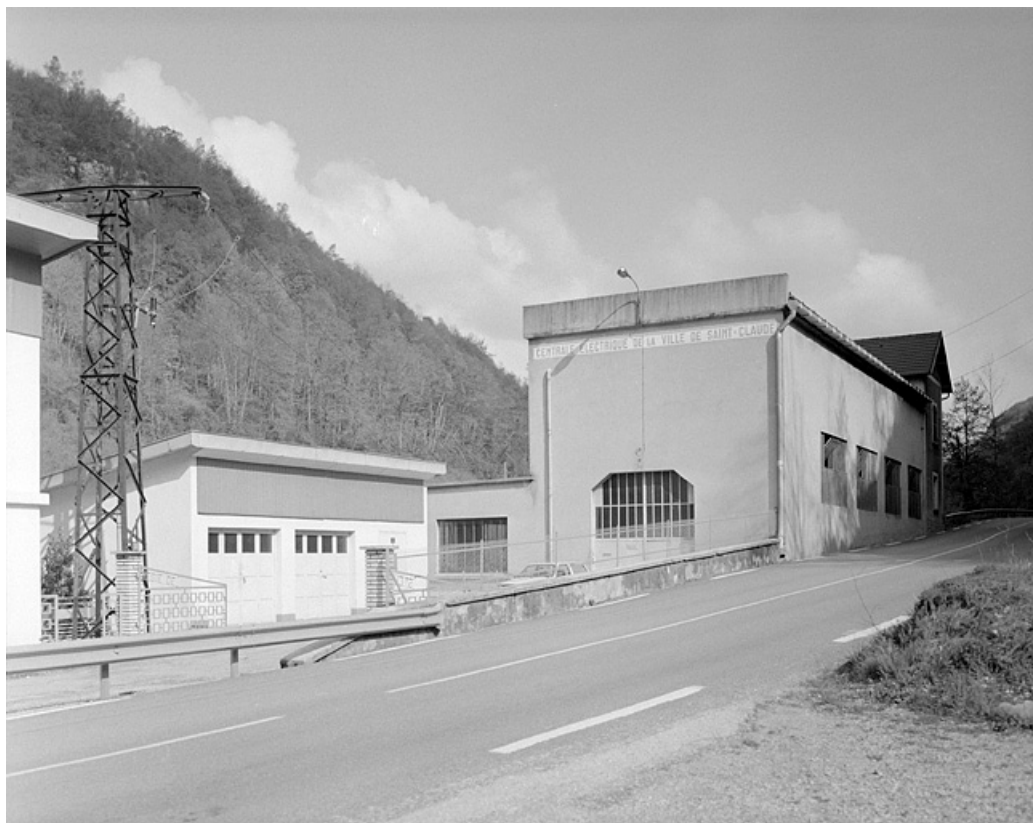
Façade antérieure de la centrale.
