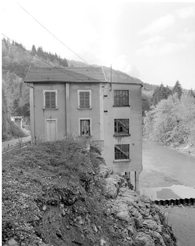
Façade postérieure de la centrale.
