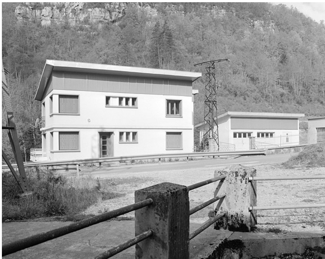
Logement d'ouvriers et remise d'automobile.
