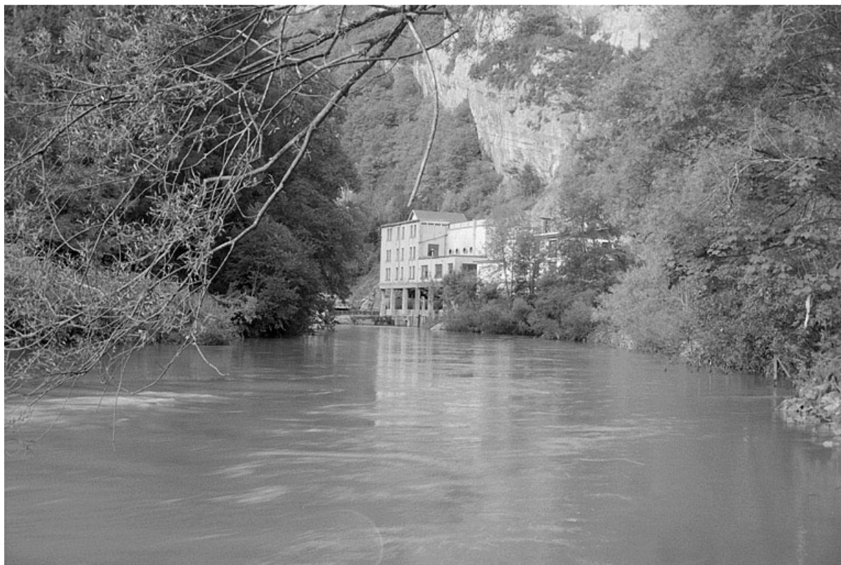
Vue d'ensemble, depuis l'aval.
