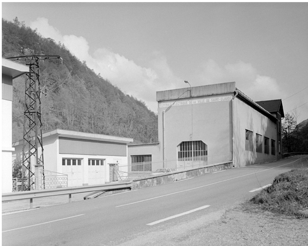
Façade antérieure de la centrale.
