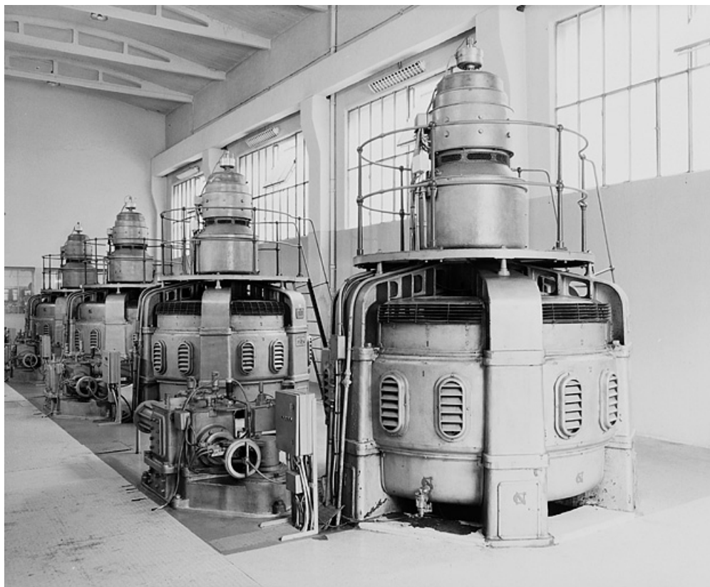
Vue d'ensemble des alternateurs.
