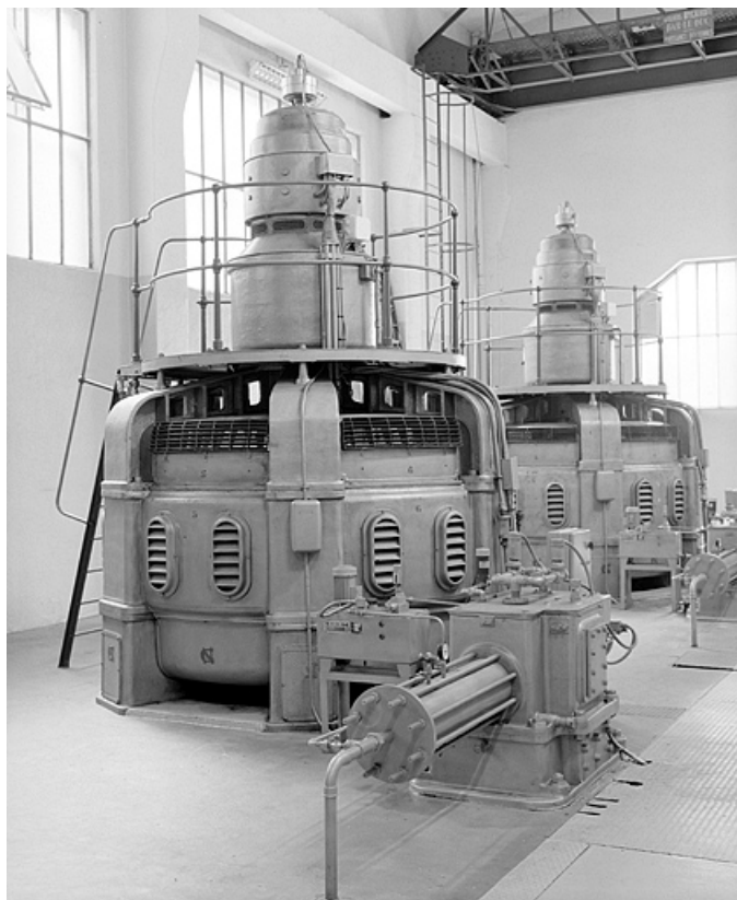
Régulateur, pivoterie et alternateur de 2 groupes.
