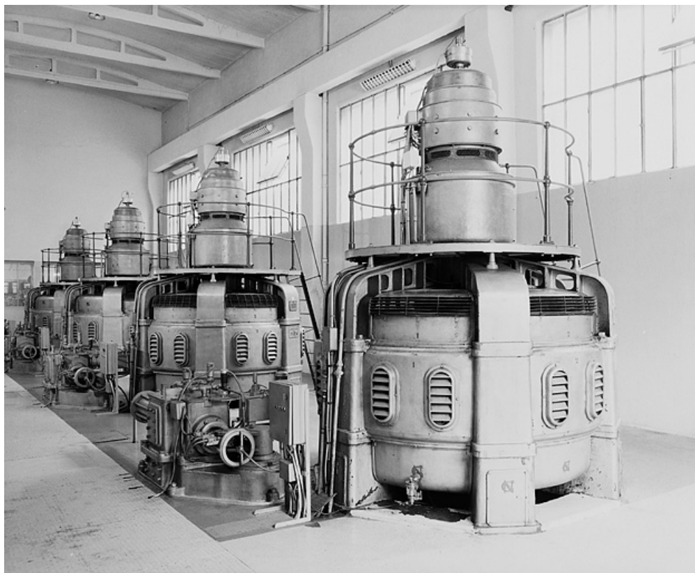
Vue d'ensemble des alternateurs.
