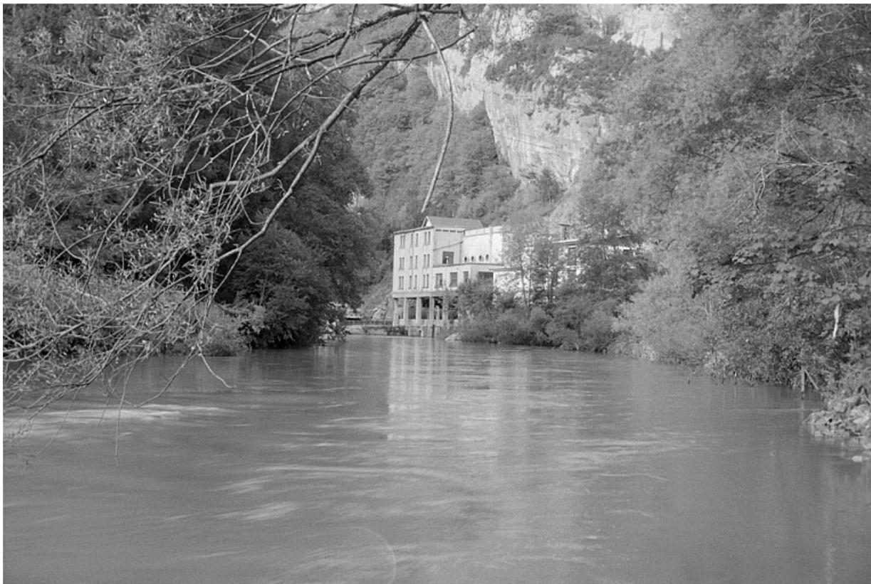
Vue d'ensemble, depuis l'aval.
