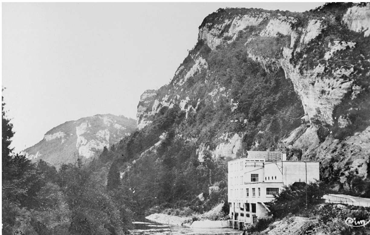
Chassal (Jura). Centrale électrique de St-Claude.
