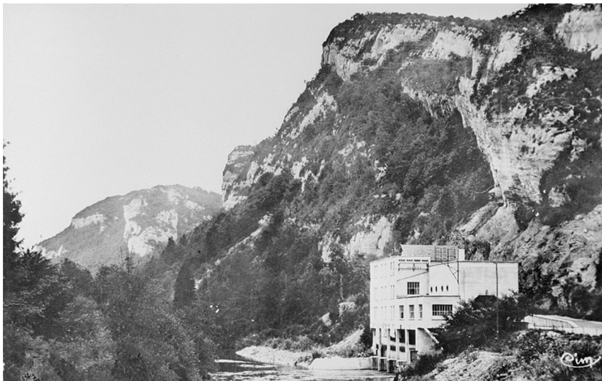
Chassal (Jura). Centrale électrique de St-Claude.
