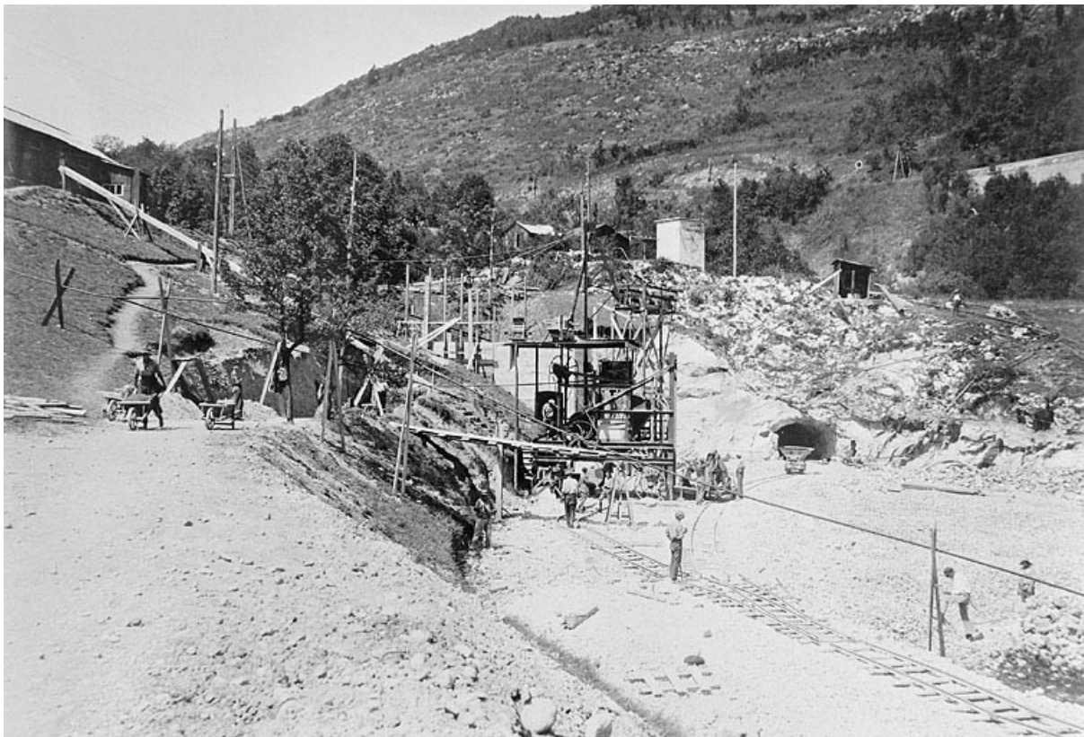
Chantier du barrage. Poste de transformation et compression d'air n° 1. Mur de rive de la prise d'eau. Chantier de concassage et de broyage et bétonnière. Alimentation d'eau et magasin des chaux et de ciment.
