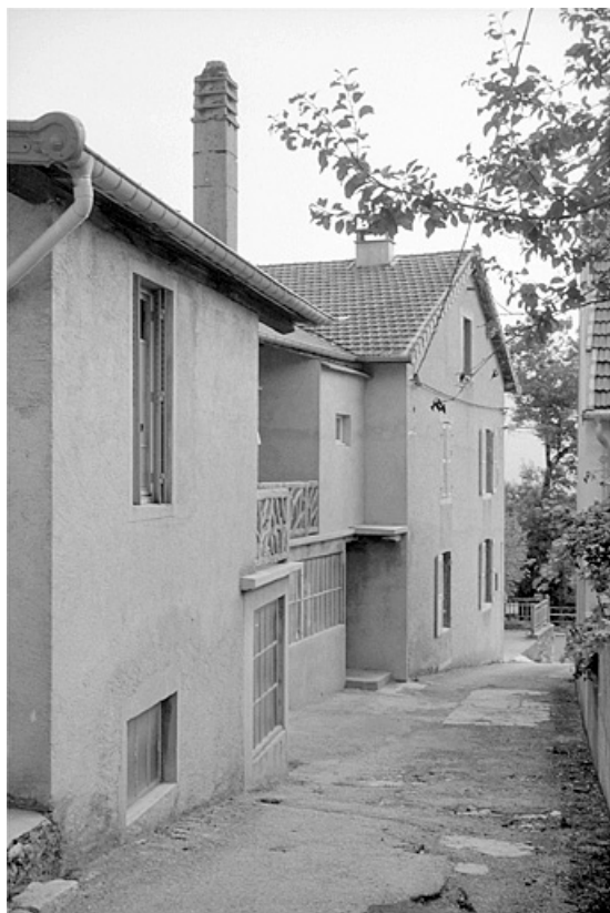
Tournerie désaffectée et logement patronal (I, J), vus du sud-ouest.
