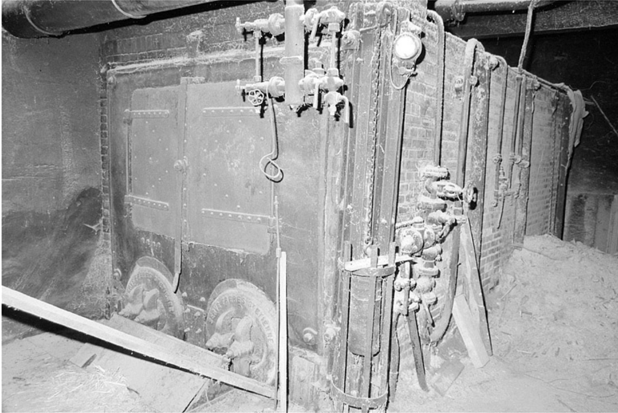
Chaudière de la machine à vapeur.
