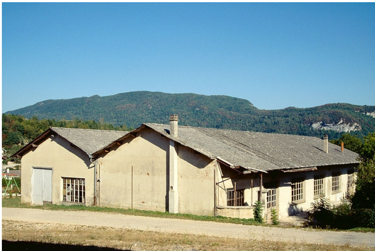
Atelier de fabrication (scierie), vu depuis l'ouest.
