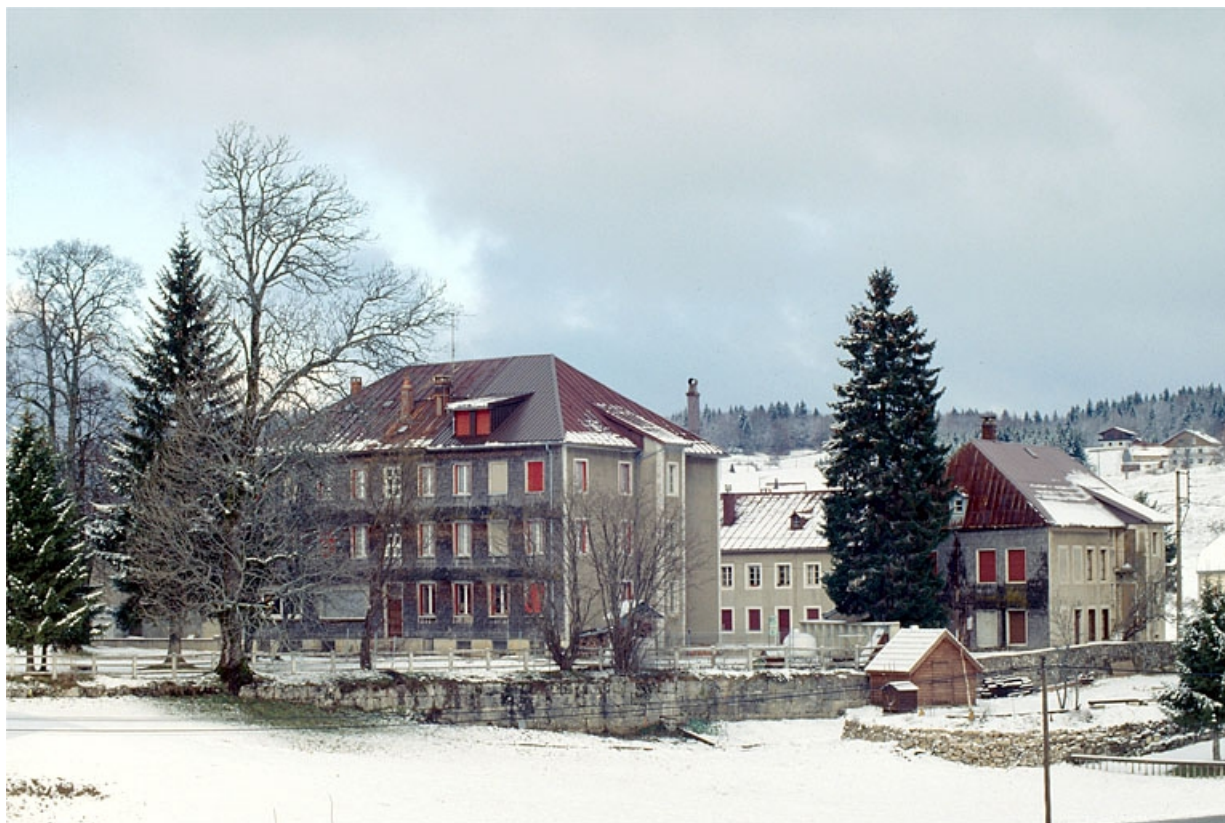
Vue d'ensemble depuis le sud-est, en hiver.
