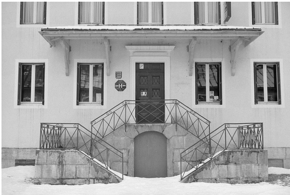
Escalier extérieur de l'atelier de fabrication.
