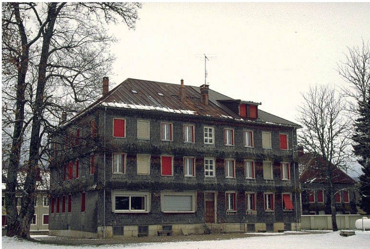
Façade postérieure de l'atelier de fabrication, en hiver.
