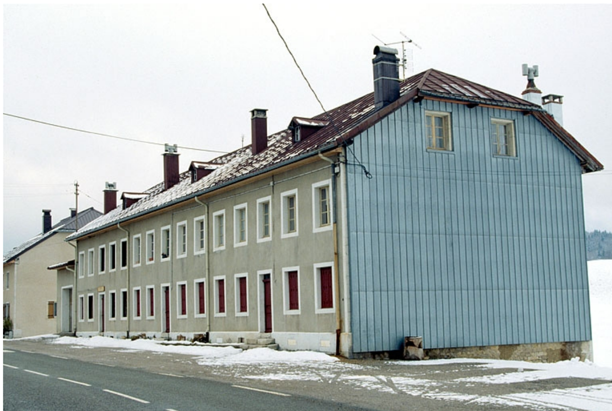
Logement d'ouvriers vu de trois quarts droit, en hiver. 39, Lajoux
