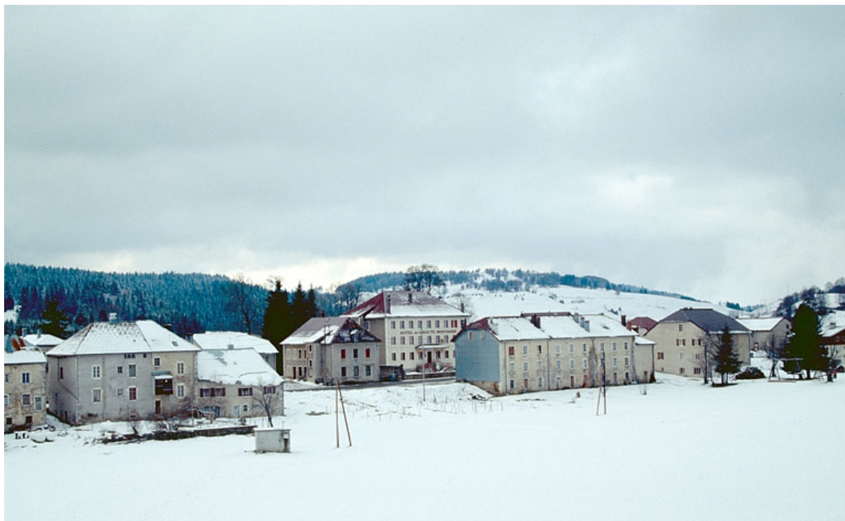
Vue d'ensemble depuis le nord-est, en hiver. 39, Lajoux
