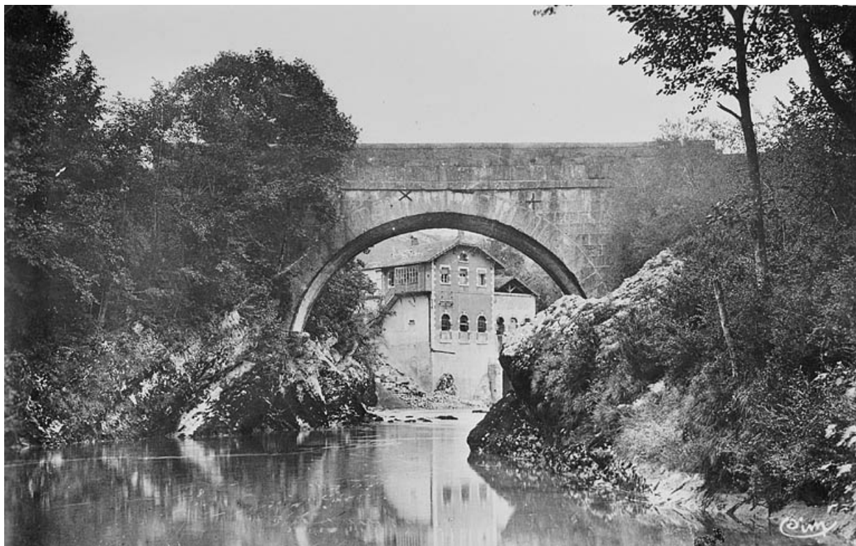
Molinges - Chassal (Jura). Pont des fours à chaux.
