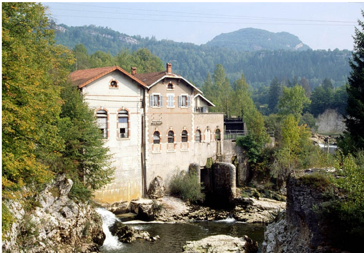
Façade sur la Bienne, depuis le pont.
