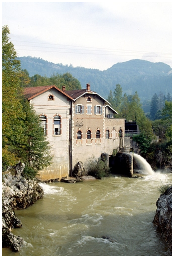
Façade sur la Bienne, par temps de crue.
