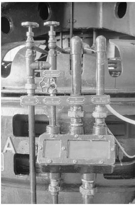
Alternateur ASEA : détail des conduits de graissage.
