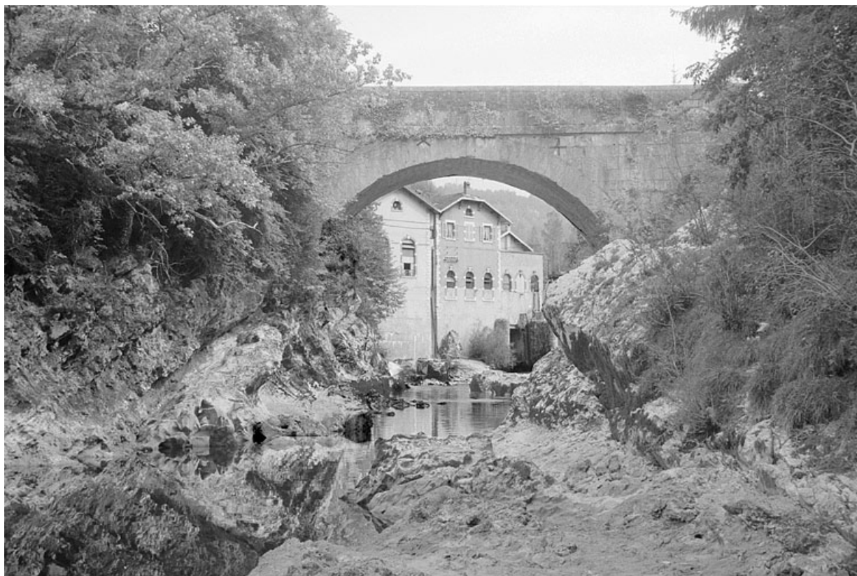
Façade sur la Bienne, depuis le lit de la rivière en aval du pont.
