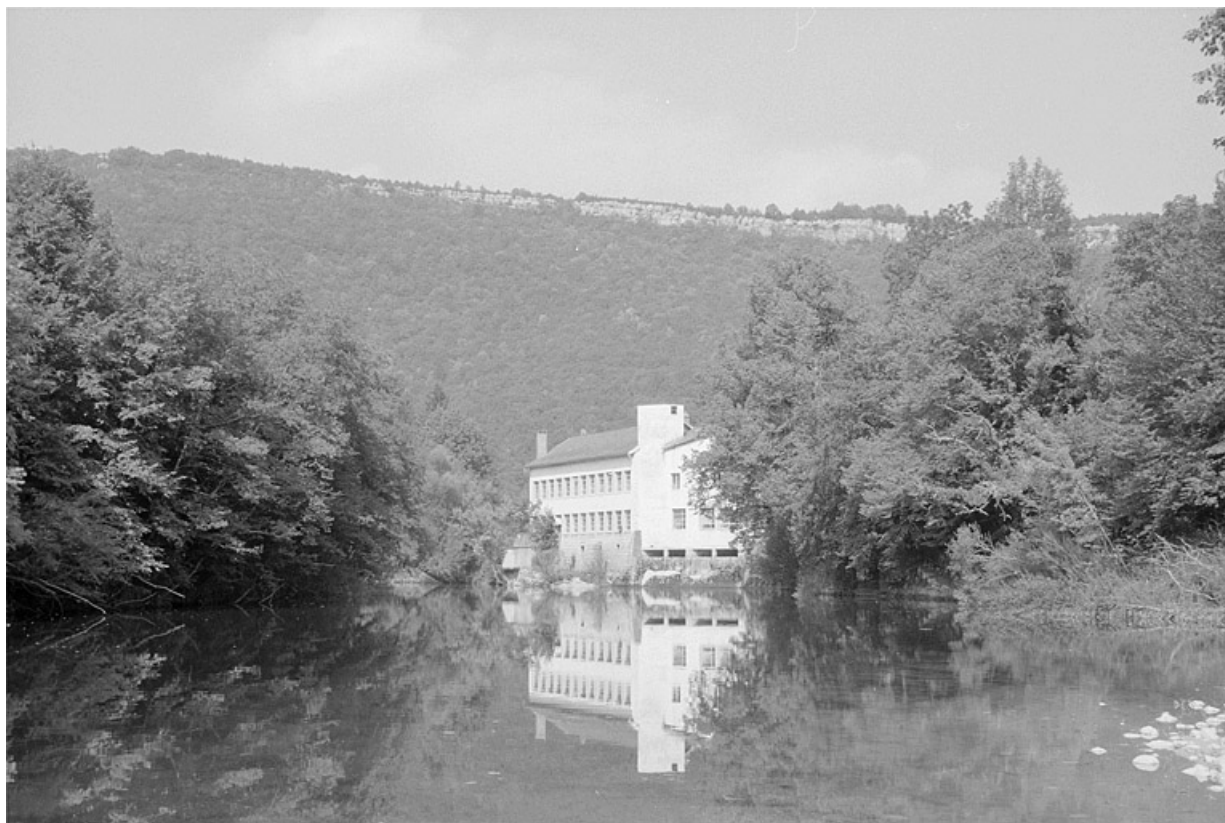
Vue d'ensemble, depuis le sud-est (amont).
