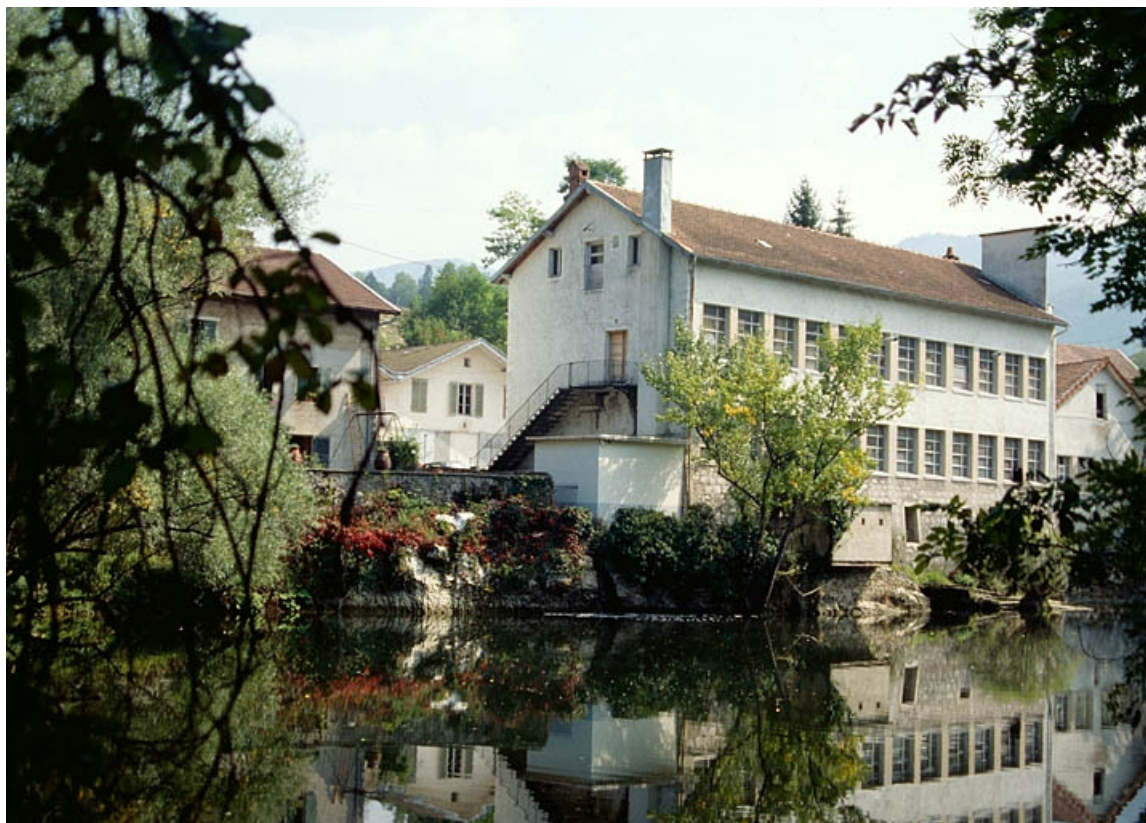
Atelier de fabrication, depuis le nord-ouest (aval).
