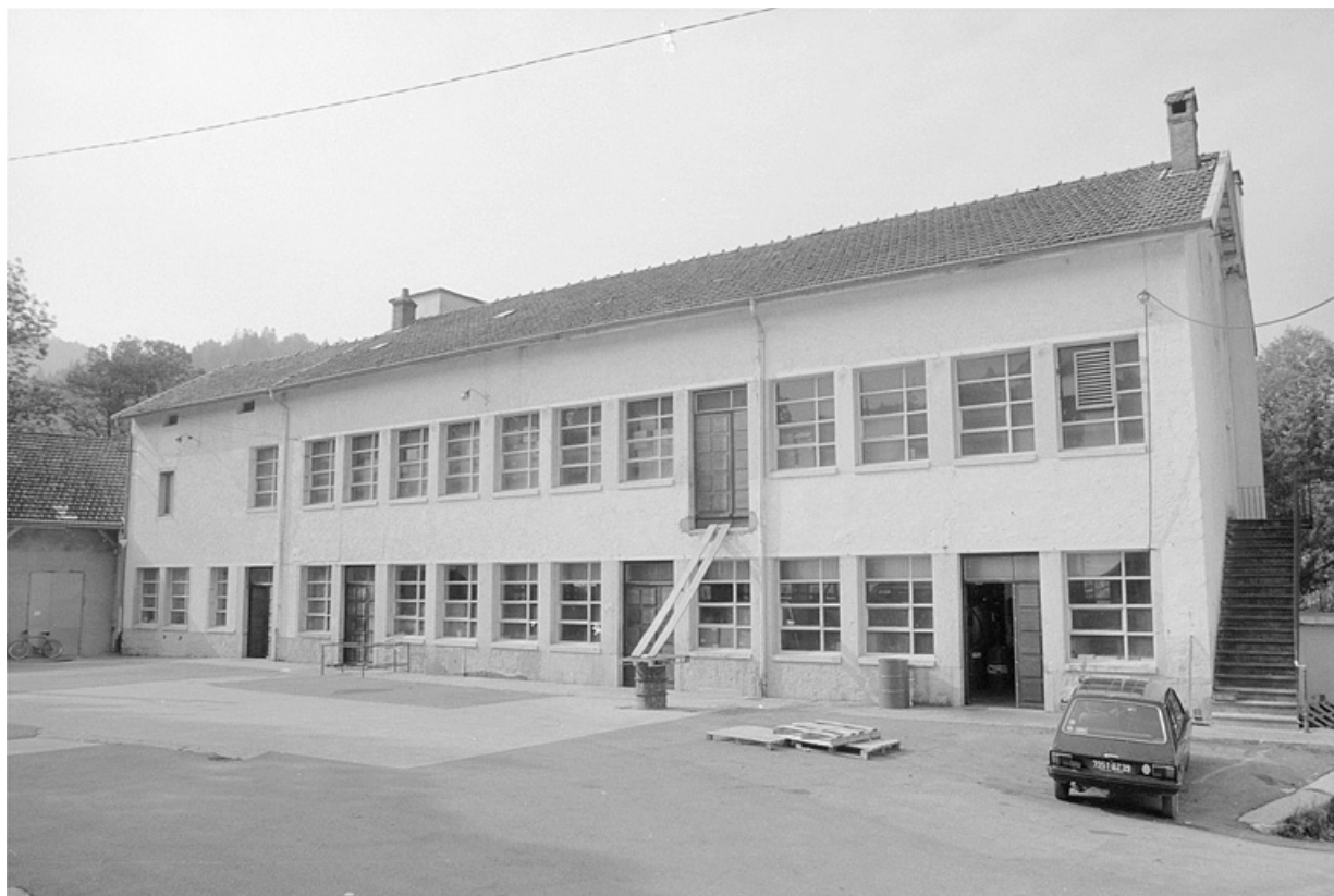
Atelier de fabrication, depuis la cour. 39, Chassal, lieudit : Moulin de Marignat
