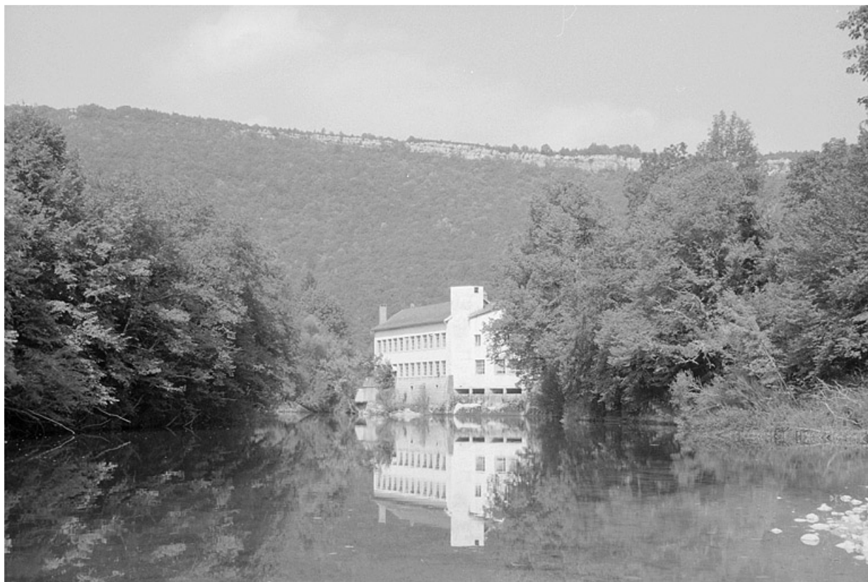
Vue d'ensemble, depuis le sud-est (amont).
