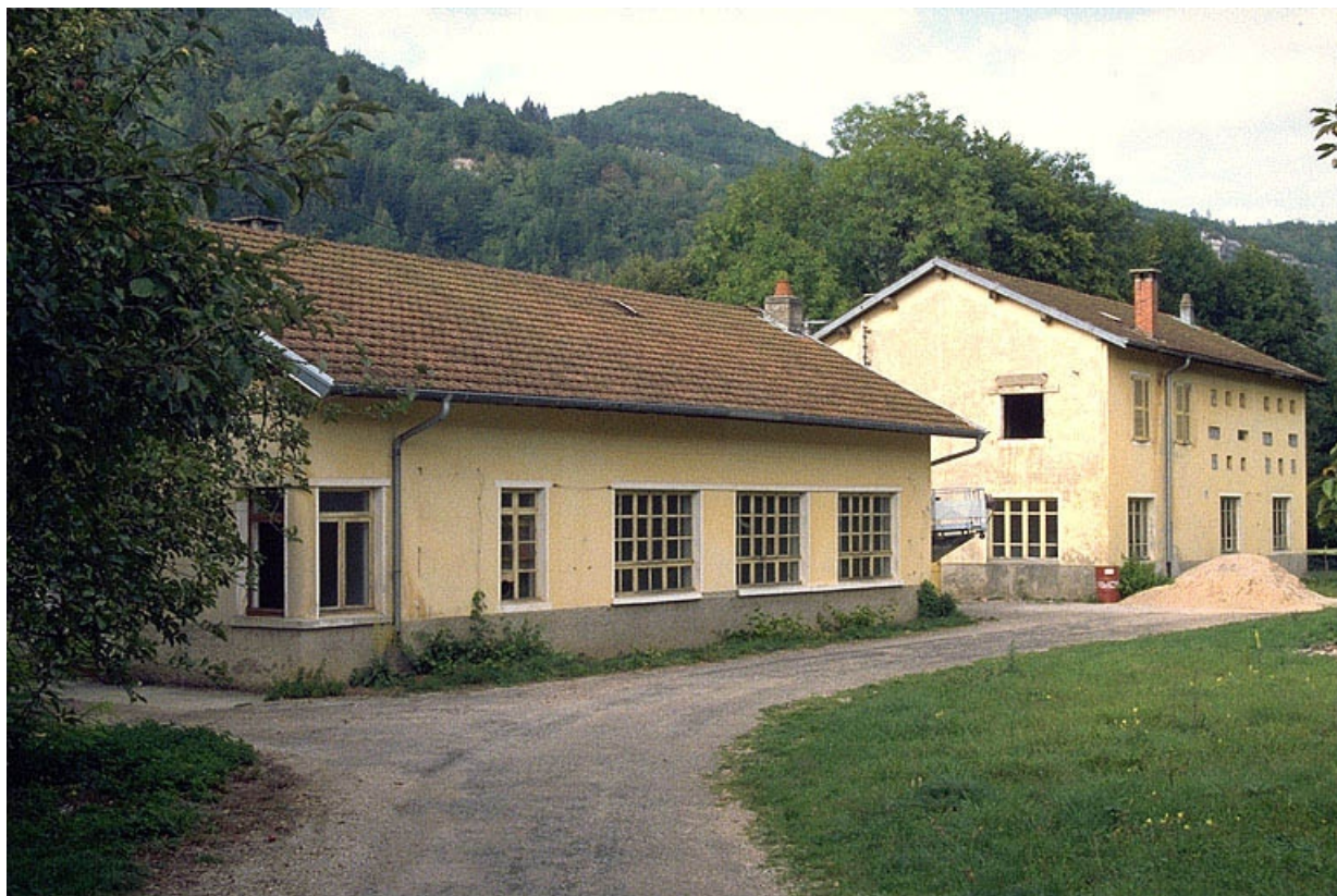
Bâtiments depuis l'entrée.
