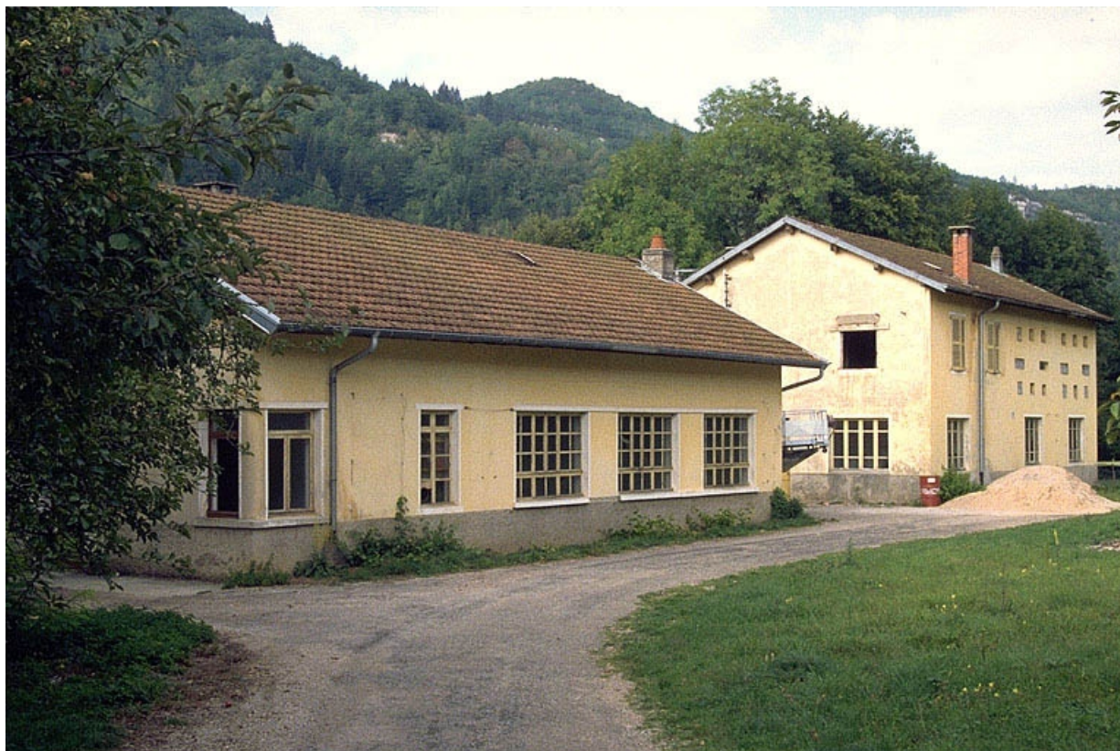
Bâtiments depuis l'entrée.
