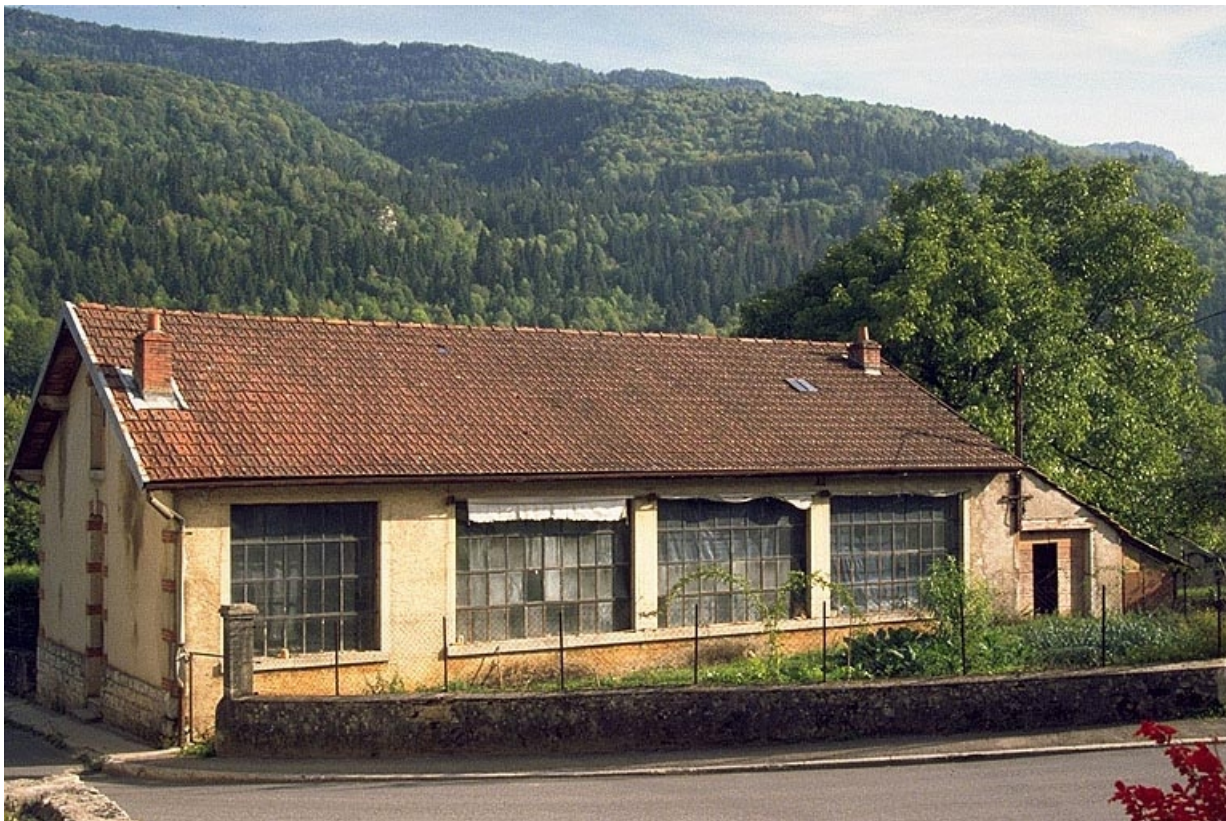
Façade latérale droite de l'atelier de fabrication.
