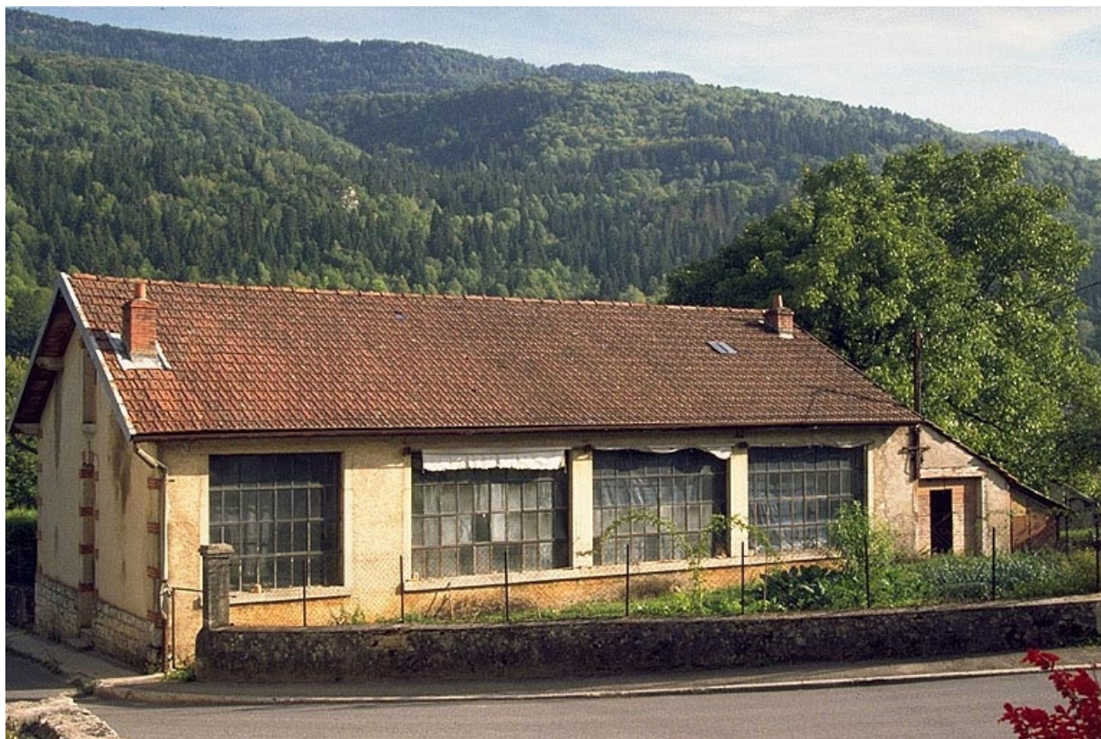
Façade latérale droite de l'atelier de fabrication.
