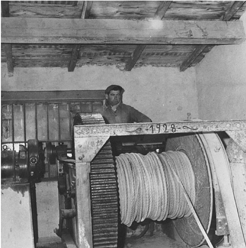
Tirage d'un bloc sur le chantier : le treuil.
