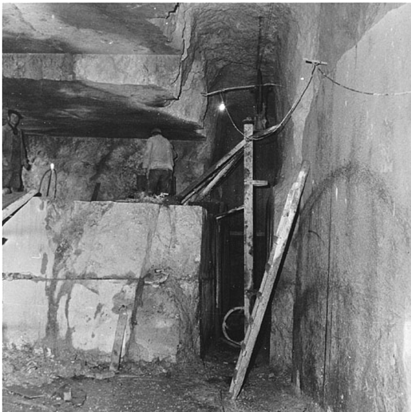
Intérieur de la carrière : fil hélicoïdal en place après dégagement des stériles. 39, Chassal, lieudit : à la Carrière
