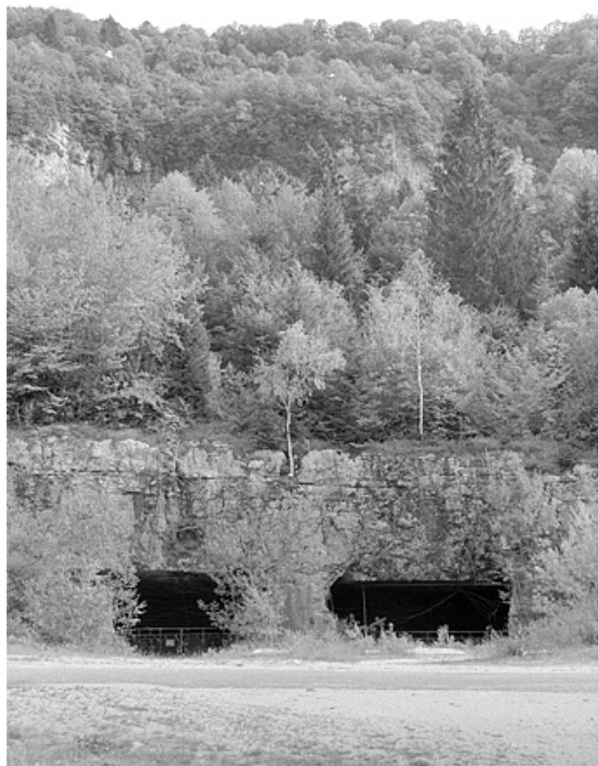
Entrées de la carrère souterraine (en 1990), partie centrale.
