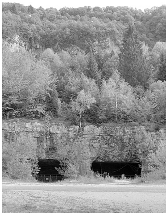
Entrées de la carrière souterraine (en 1990), partie centrale.
