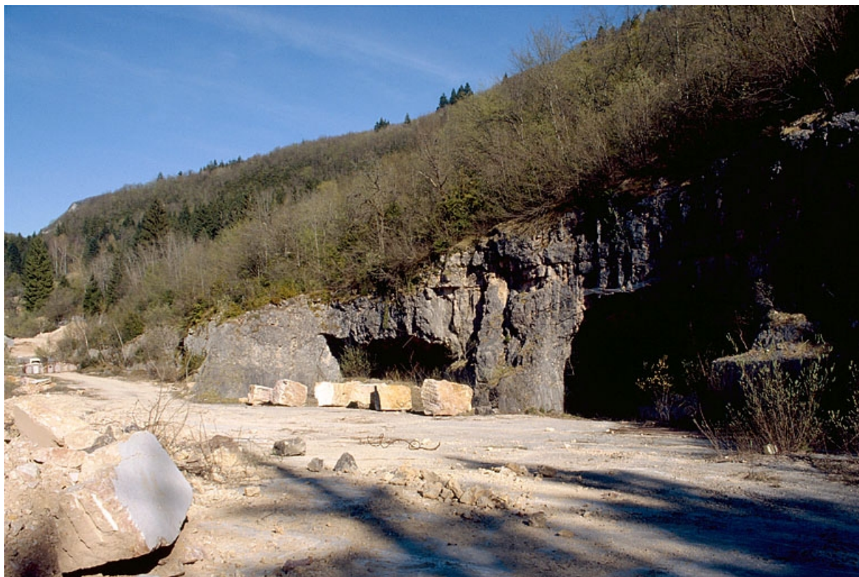
Entrées de la carrière souterraine, partie sud-ouest.
