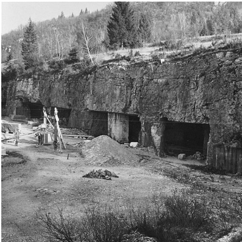
Chantier et entrées de la carrière souterraine.
