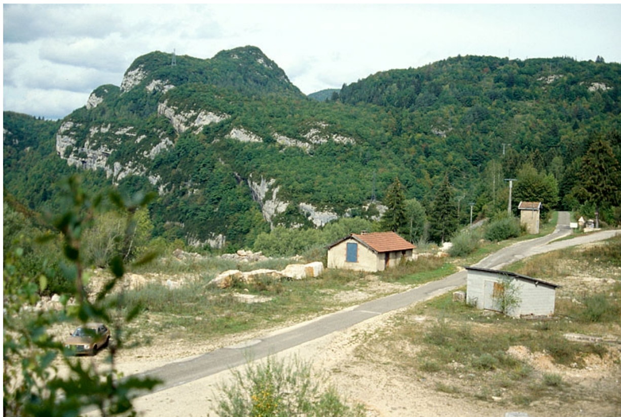
Bâtiments depuis le sud-est. Cantine et vestiaire à gauche, atelier de réparation à droite.
