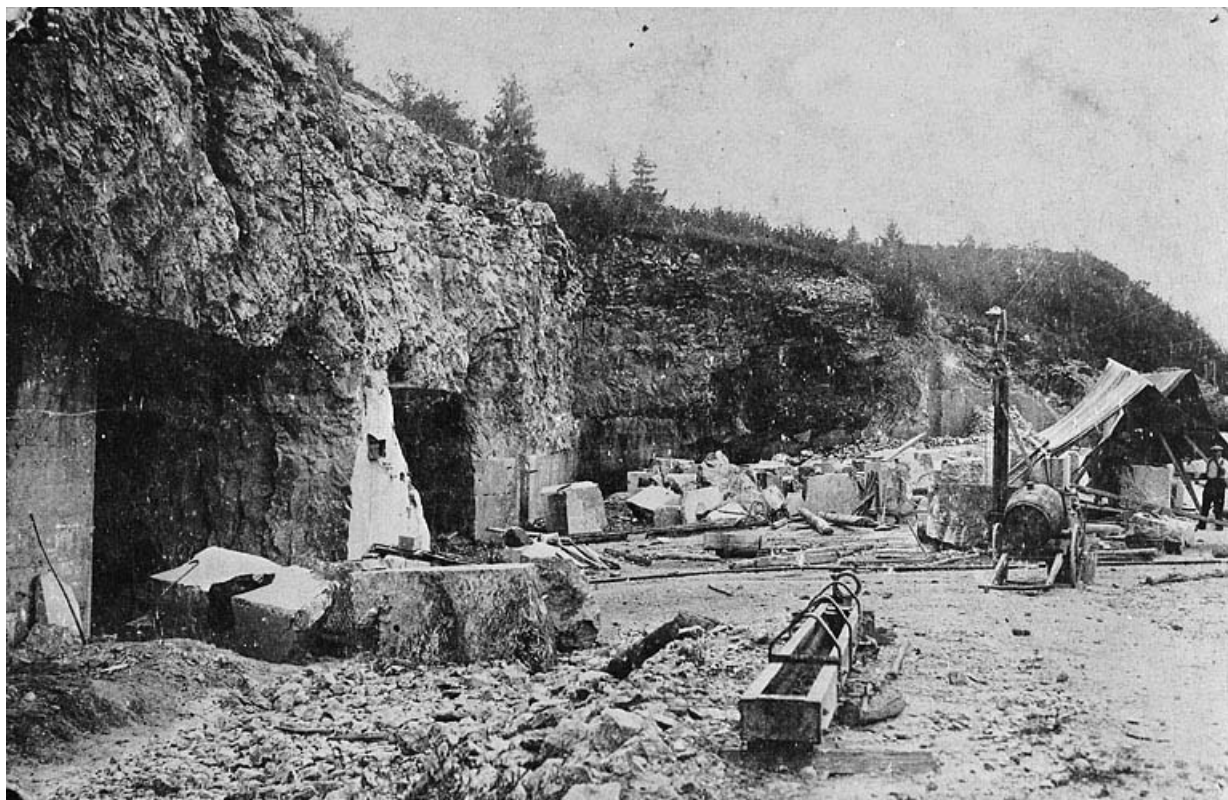
Chantier et entrées de la carrière souterraine.
