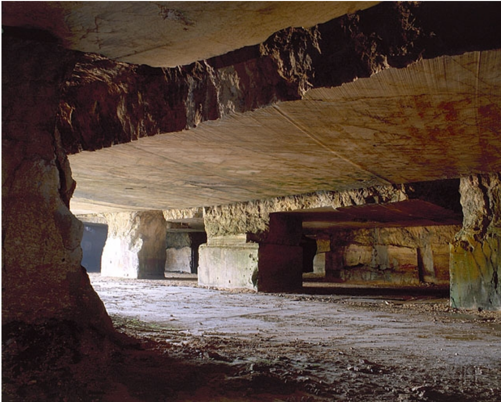
Intérieur, partie centrale, près d'une entrée.
